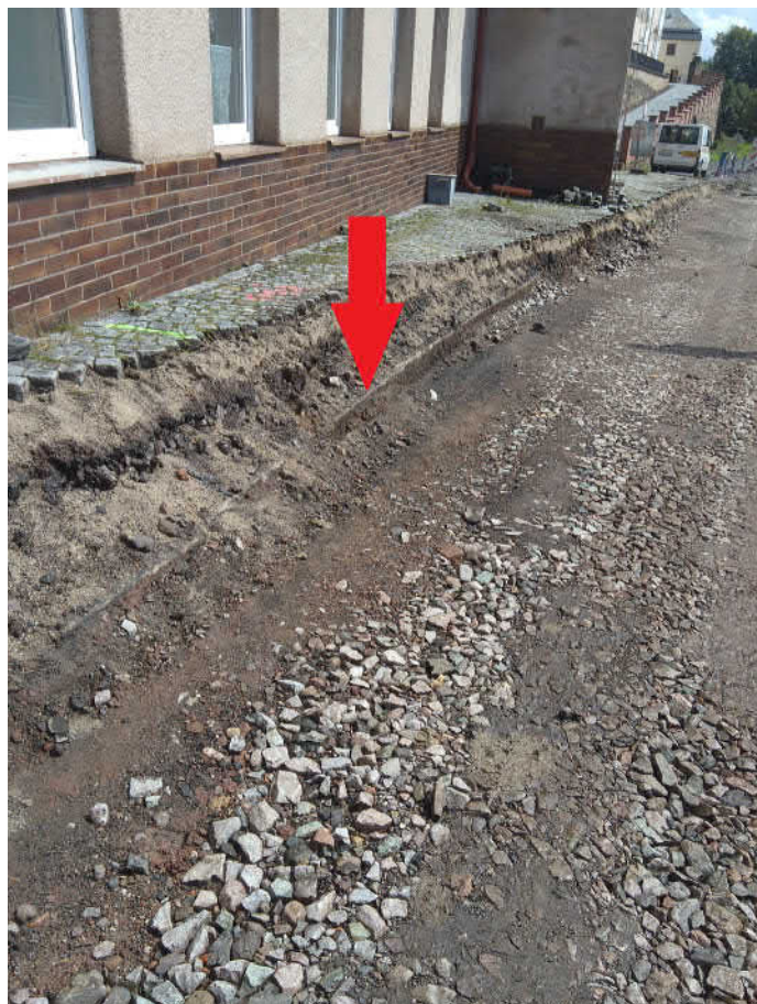
Při rekonstrukci silnice pod restaurací Střelnice byly objeveny zbytky původní dlážděné silnice. Ta stávající je překvapivě 50 – 60 cm nad původní silnicí.
