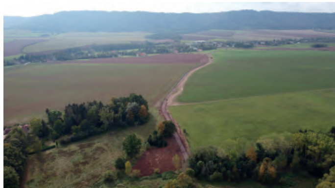
Pohled na cyklostezku směrem na Křinice před položením asfaltového povrchu.
