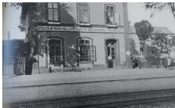
Olivětín - staniční budova, 1939
