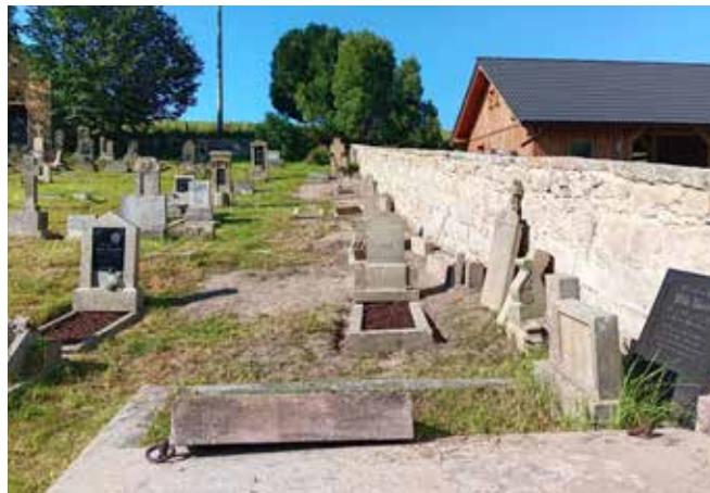
Opravená hřbitovní zeď ve Zdoňově
