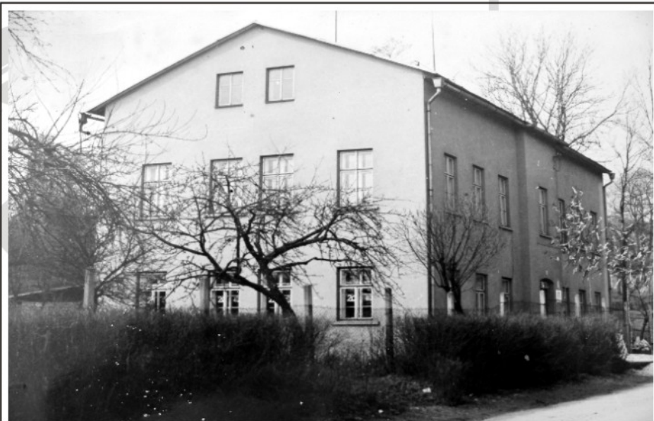
Školní budova v padesátých letech minulého století
