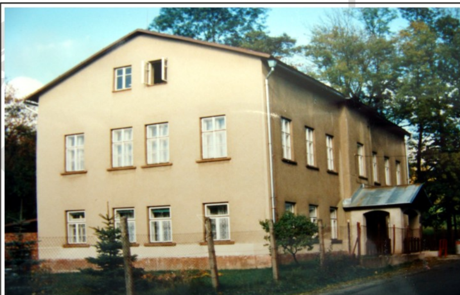
Škola po roce 1996, kdy byly provedeny protiradonové úpravy a vnitřní opravy pravé (severní) části budovy.
