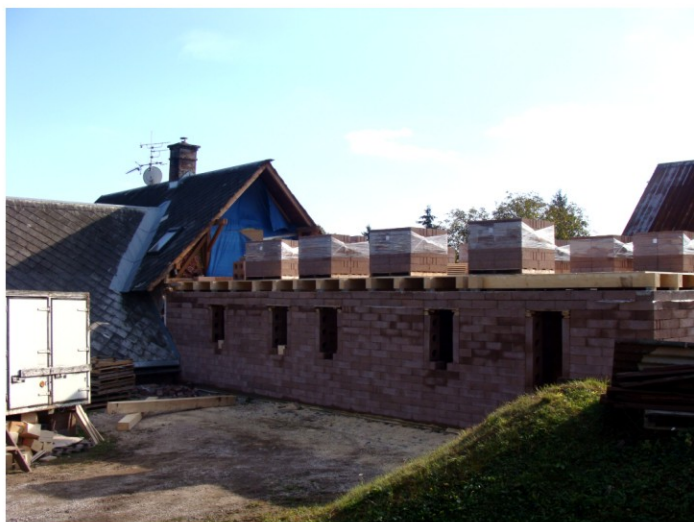
Čistá. Stavební úpravy bývalé hospodářské části čp.92. Přístavba druhé bytové jednotky. Provádí Pavel Kraus.
