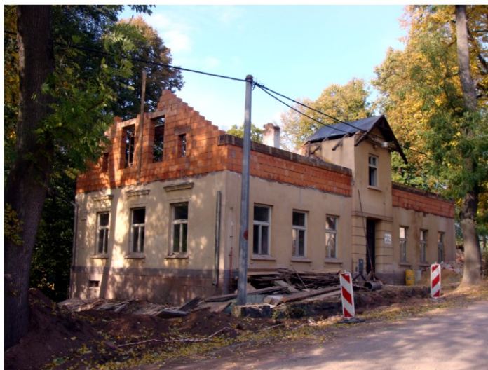
Pokračují úpravy objektu bývalé školní kuchyně a jídelny ve Fořtu
