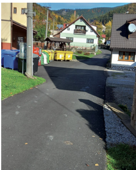
Komunikace pod úřadem Městysse
