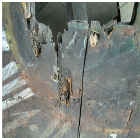
Stav před restaurováním po odstranění plechového potahu
