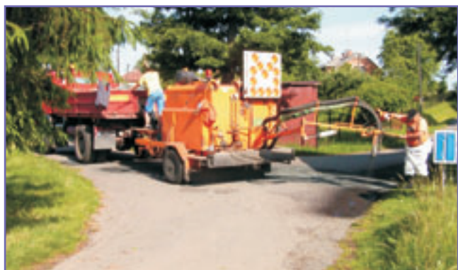
Zároveň byla zahájena oprava místních komunikací tryskovou metodou Patschmatik.
