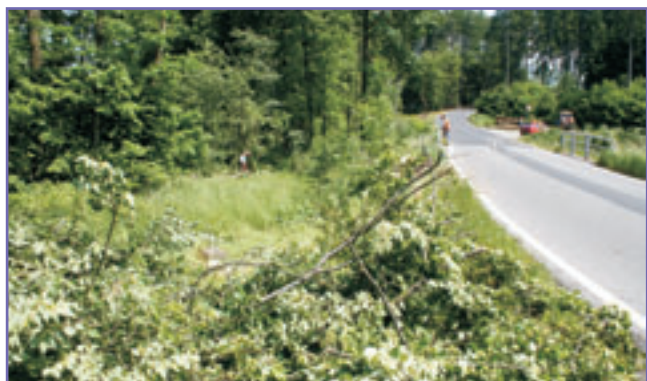
Ke konci jara se rozbíhaly největší investiční akce našeho města letošního roku. Fotografie je z akce "Chodník Stolín - Červený Kostelec", kde v prostoru odbočky na čistírnu odpadních vod a mostu přes potok Olešnice bylo nejprve třeba vykácet některé dřeviny.
