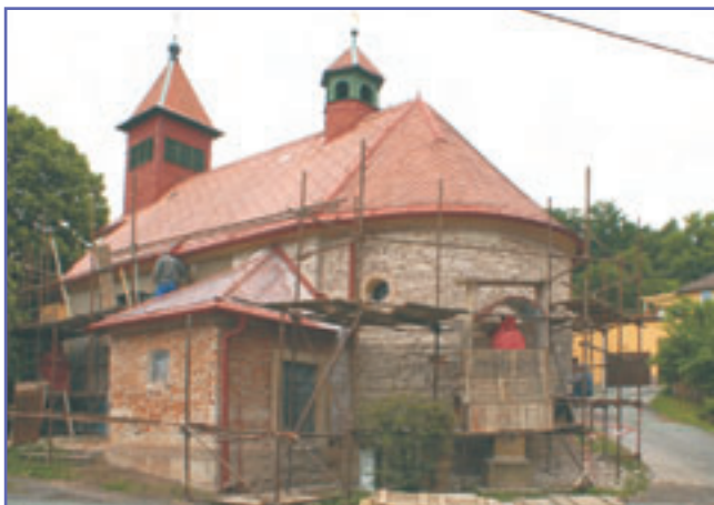
Oprava fasády kaple na Bohdašíně
