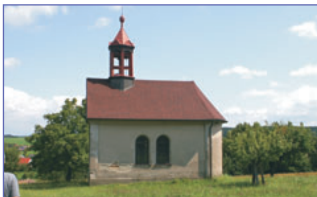
Novou střechu kaple v Olešnici obdivují i cestující vlakem
