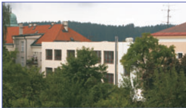
Oprava zadní části základní školy byla dokončena
