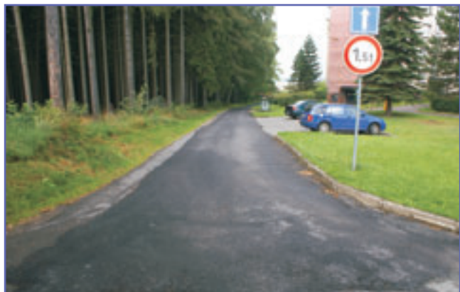
Opraven byl povrch místní komunikace U Kaštánku až ke Koubovce.
