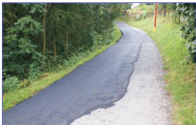
Opraven byl také povrch místní komunikace z ulice Severní k Lipkám.
