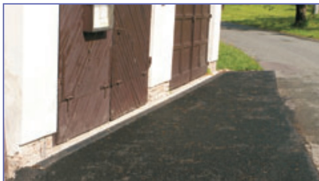
Upravený vjezd do hasičské zbrojnice na Bohdašíně
