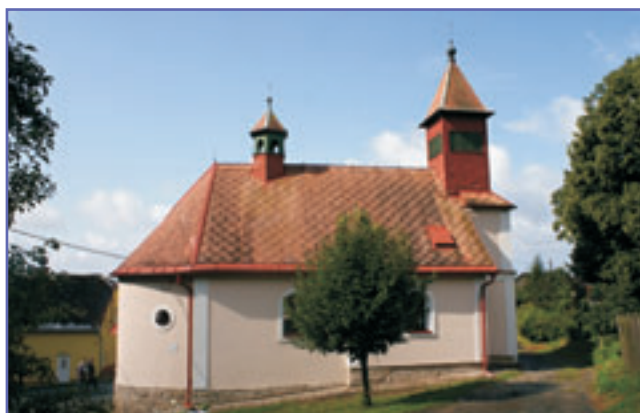
Nová fasáda kaple na Bohdašíně září příjemným okrem
