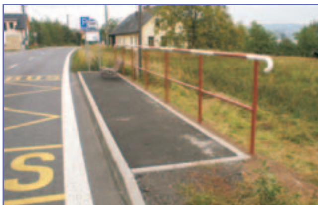
Nové nástupiště na autobusové zastávce Devět Křížů.
