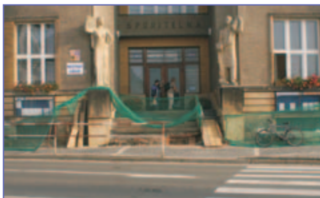
Oprava soklu a schodiště městského úřadu.
