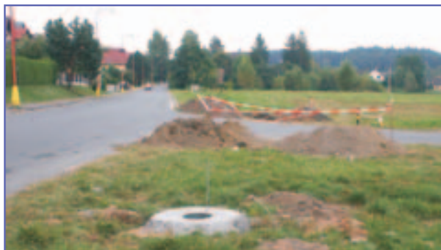
Rekonstrukce veřejného osvětlení ulice 5. května.
