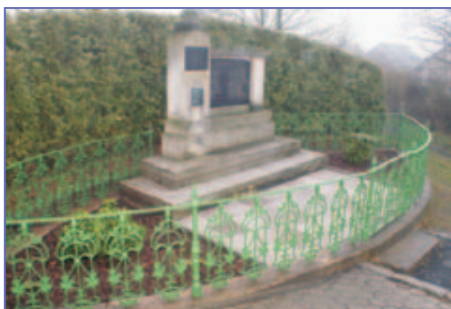
Památník padlých ve Stolíně - Byla provedena oprava dlažby, údržba a nová výsadba zeleně, oprava a nátěr oplocení. Karel Cejnar a Oldřich Nermut
