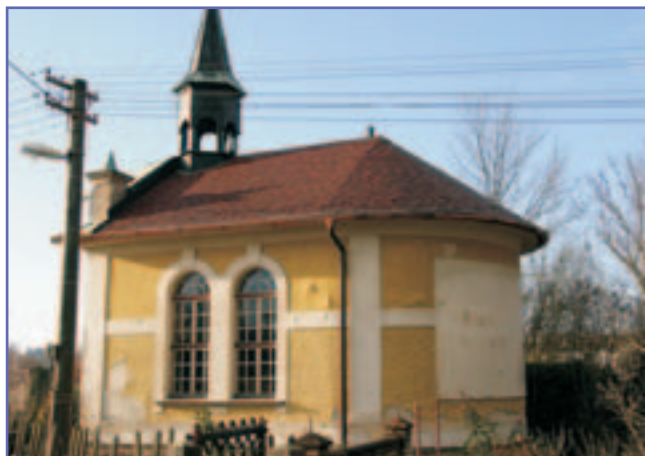
Kaplička ve Lhotě - Byla provedena výměna střešní krytiny včetně oplechování.
