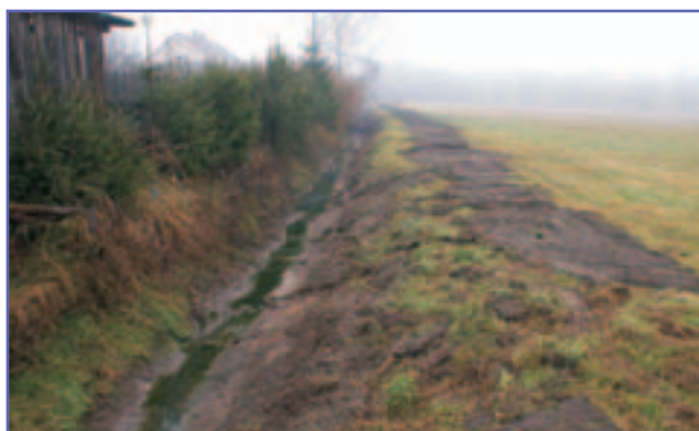
Vyčištění sběrného melioračního kanálu v Olešnici - Město společně se zemědělskou vodohospodářskou správou zajistilo vyčištění a vysečení kanálu.
