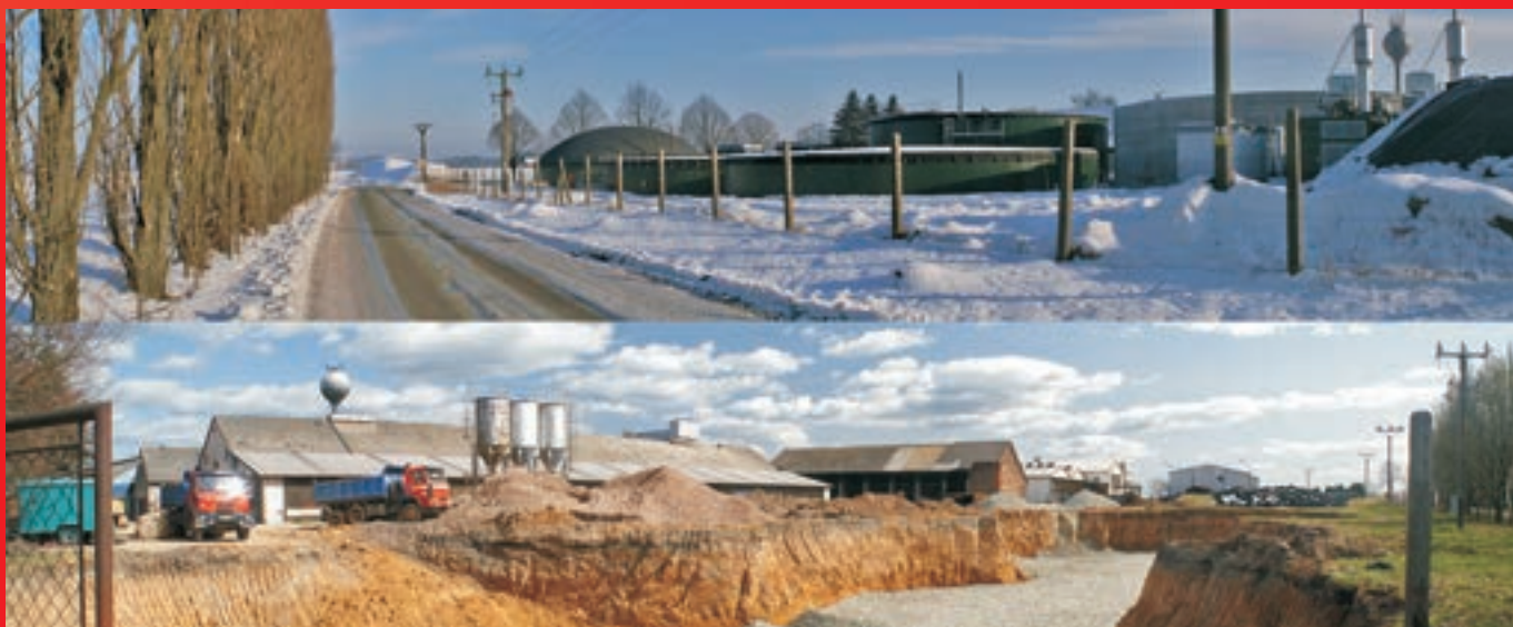
Podoba biostanice krátce po zahájení stavby a v období zkušebního provozu.
