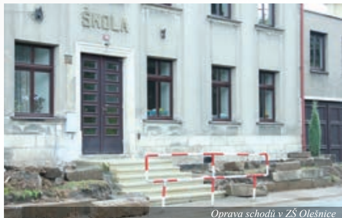
Oprava schodů v ZŠ Olešnice
