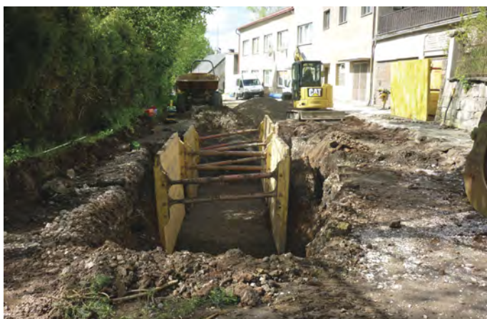
V ulici Jiráskova se pilně pracuje. Do země je pokládána nová kanalizace a další inženýrské sítě. Foto: Jiří Mach
