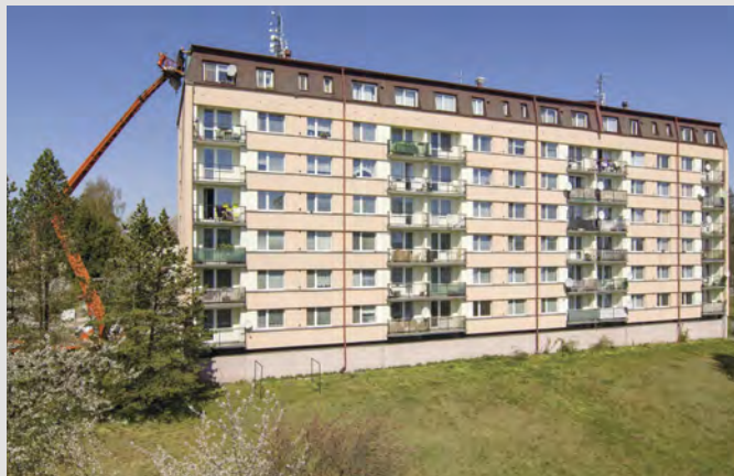
Jan Kutílek: Oprava střechy na Větrníku
