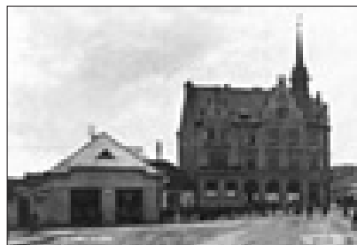
Záloženský dům a budova mototechny
