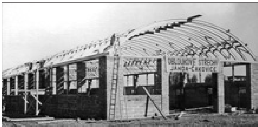
Stavba továrny v Satalicích
