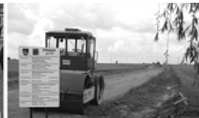
Začala výstavba místní příjezdové komunikace k průmyslové zóně, která by měla odlehčit městu hlavně od průjezdu kamionů
