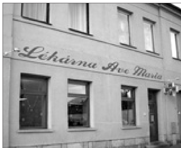
Lékárna Ave Maria vznikla v blízkosti nového zdravotního střediska v roce 2004
