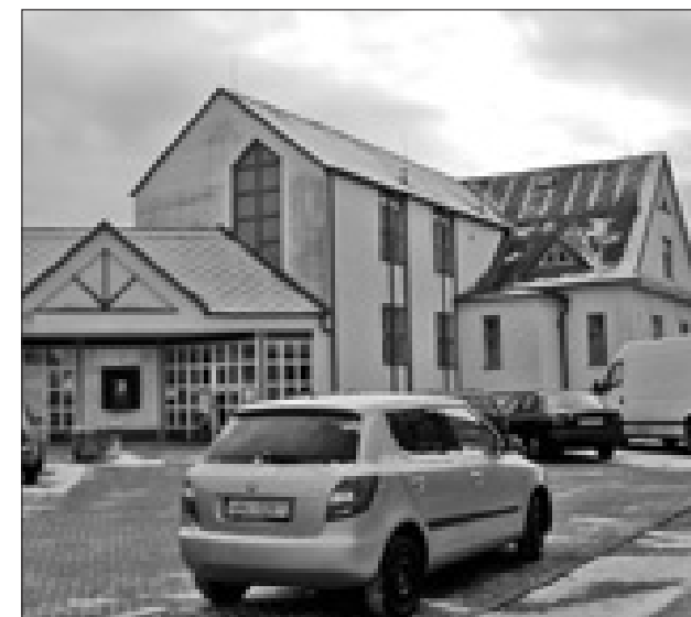
Městské zdravotní středisko bylo vybudováno v polovině devadesátých let dvacátého století
