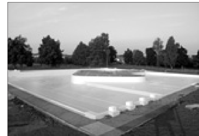
Dnešní nové koupaliště před dokončením v roce 2010. Bazén 62x52 m s relaxačním ostrůvkem 500 m 2 uprostřed Foto z archivu MěU
