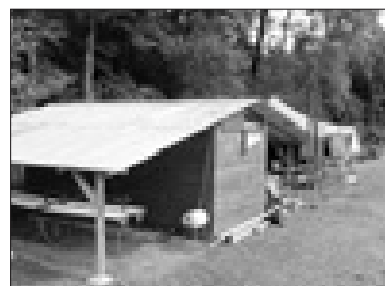
Stavba kuchyně a umyváren
