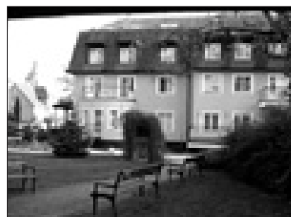
Říhova ulice 365 - domov pro seniory
