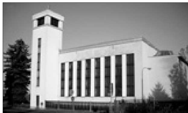
Husův sbor architekta Ferdinanda Potůčka patří k jeho slohově čistým stavbám
