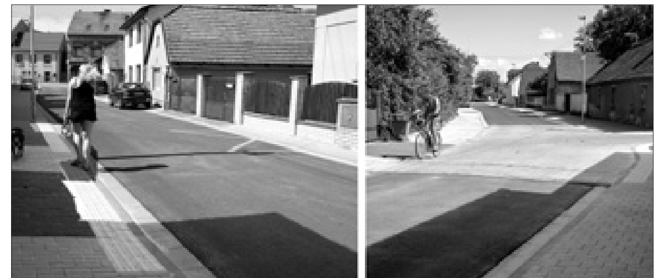
Ulice Na Hatích prošla letos náročnou generální rekonstrukcí. A tak pěší návštěvníci koupaliště půjdou po novém chodníku, motoristé zde najdou rozšířené parkovací stání. Zároveň zde byl zaveden nový vodovod a také nová kanalizace.
