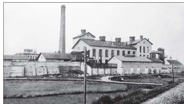
Cukrovar počátkem minulého století. V pozadí je vidět střecha novorenesanční vily, zvané Malá koruna, kterou započali v roce 1891 budovat bratři Tachauové, ale zřejmě dokončili až jejich nástupci (foto z archivu muzea)
