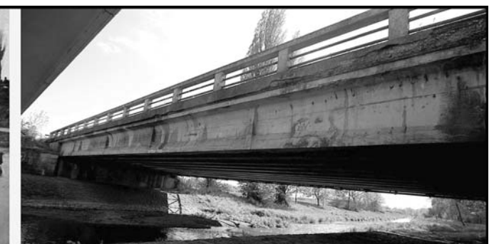
most přes Bystřici před rekonstrukcí v roce 2016
