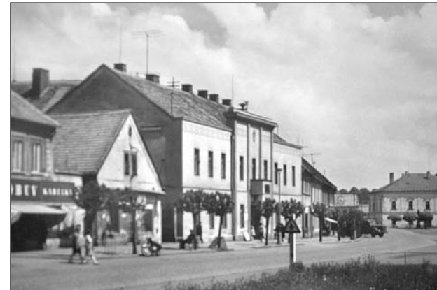
Pohled na radnici po úpravě arch. Ježka ze sedesátých let minulého století. K předchozí opravě fasády došlo v roce 1940.
