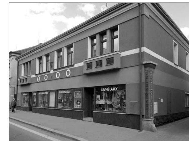
Dům č. 54 v Klicperově ulici patřil v době Protektorátu Antonínu Šetlíkovi. Při pochůzce okolo opraveného objektu si ani neuvědomujeme, že zde žili dva hrdinové a vlastenci, kteří obětovali své životy v protifašistickém odboji
