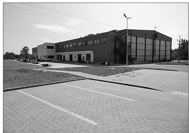
Stav stavby těsně před dokončením v srpnu 2018
