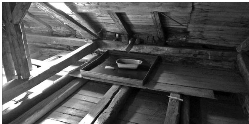
Střecha a půda radnice
