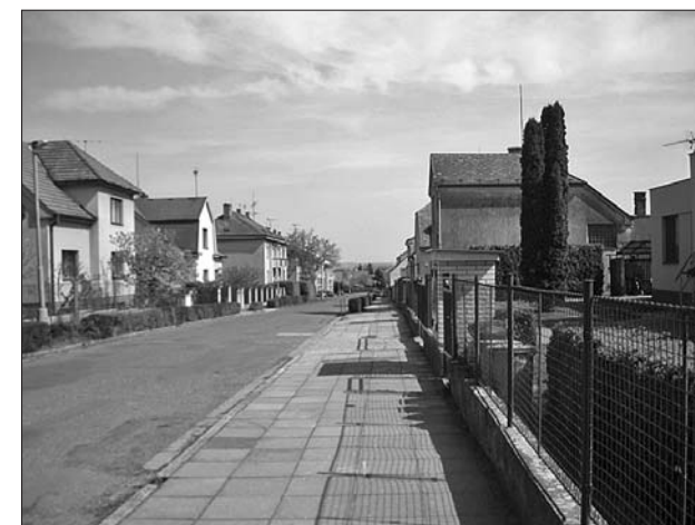
Poděbradova ulice od MŠ U Zámku před rekonstrukcí
