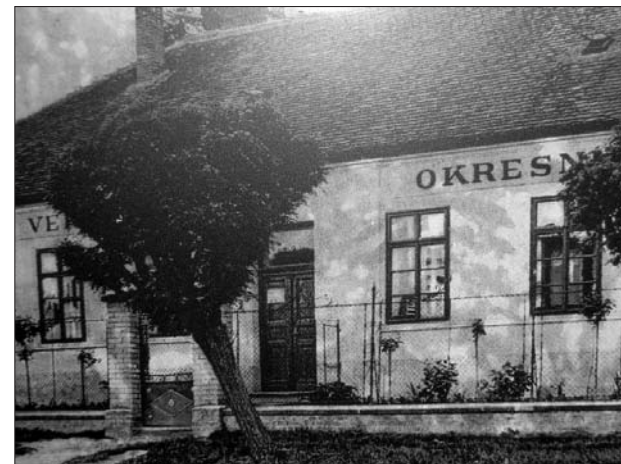
Součástí střelnice byl také restaurační a společenský objekt Střelnice, který byl v roce 1898 změněn v nemocnici (archiv muzea)
