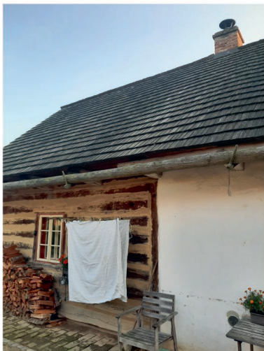
Ukázka šindelové střechy na památkově chráněné budově. Okap střechy je ručně vydlabaný ze dřeva.
