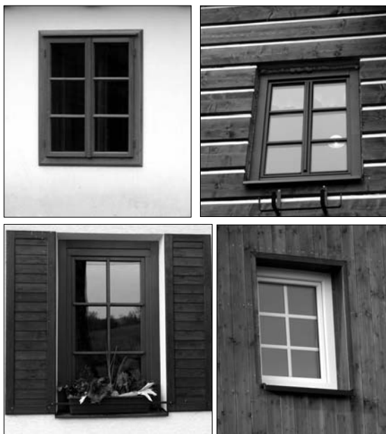
obr. 3 – 5 různé typy dělení výplní okenních otvorů (zleva od ukázkového dvoukřídlého okna, přes akceptovatelné jednokřídlé s dělením po vnější straně prosklení, třetí s odnímatelnou lištou, foto čtvrté - nevyhovující dělení pomocí meziskelních lišt)
