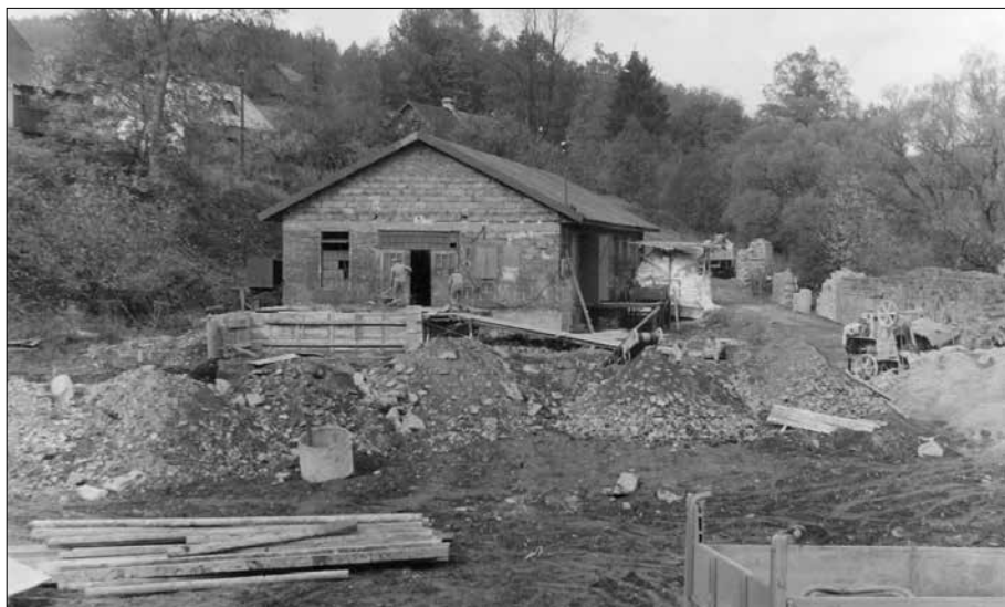
Výstavba provozovny OPK.
