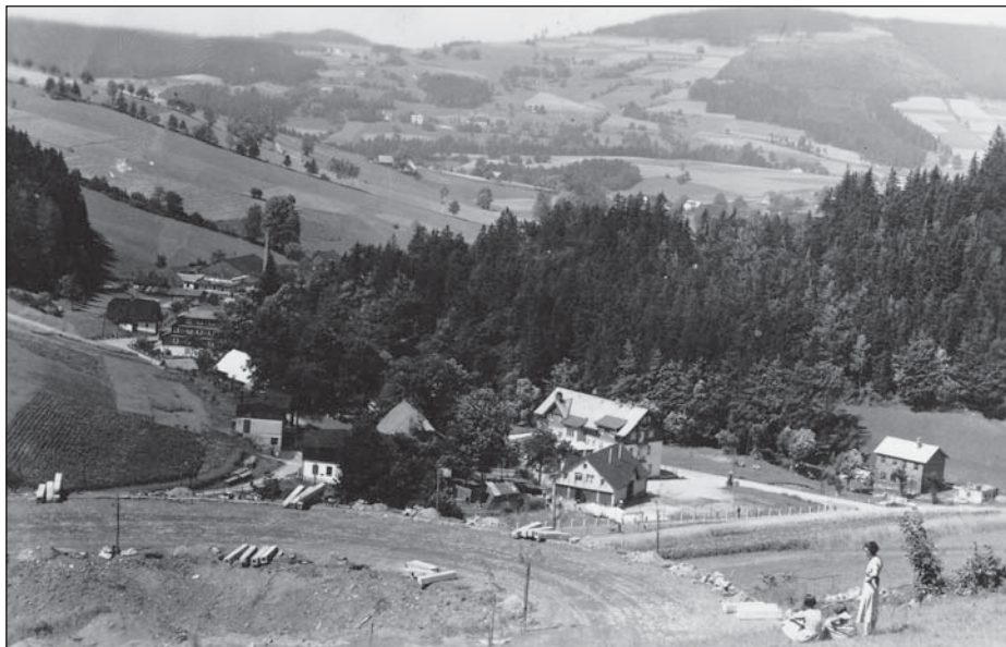
Silnice ze Zákoutí do Luisina údolí ve výstavbě.
