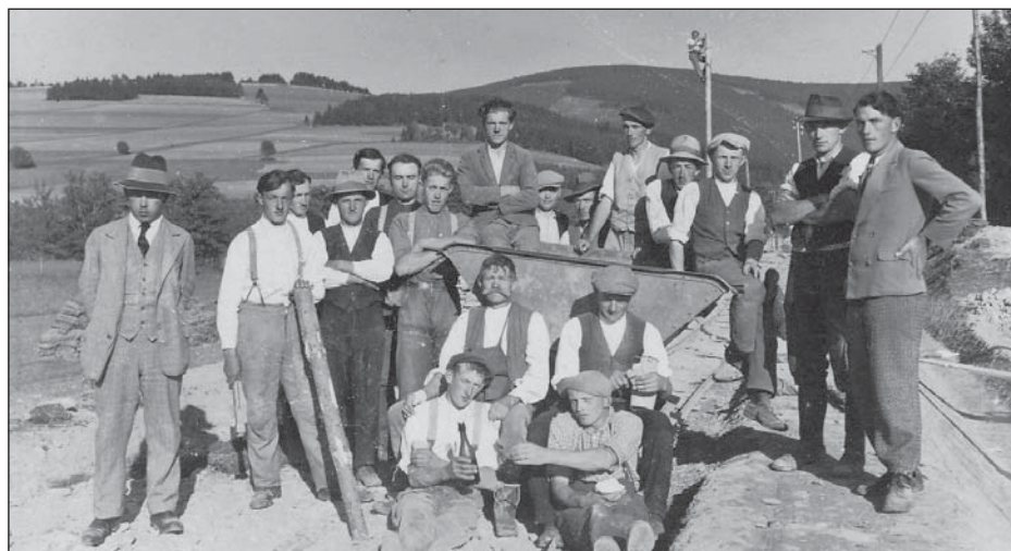
Stavba silnice z Jedlové do Zákoutí.
