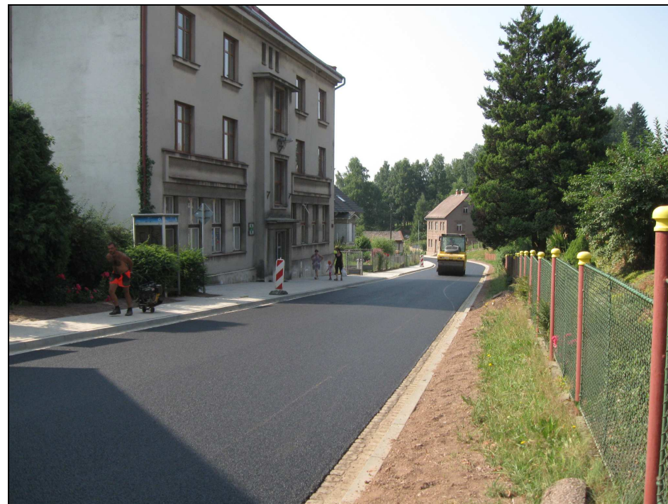
Asfaltování Rokolské ulice 29.7.2013
