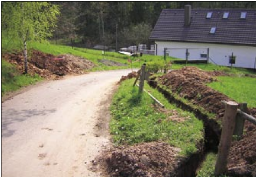
Pokládka kabelů NN a veřejného osvětlení na Popluží
