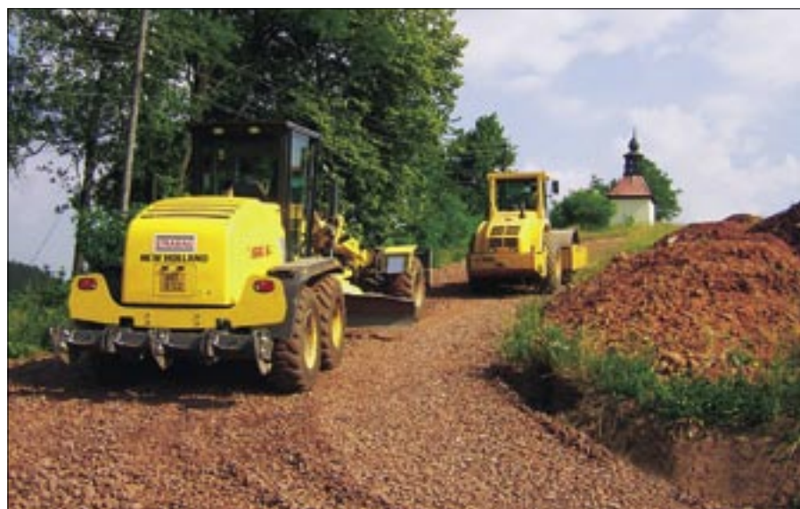
Budování příjezdové komunikace U Zvoničky
