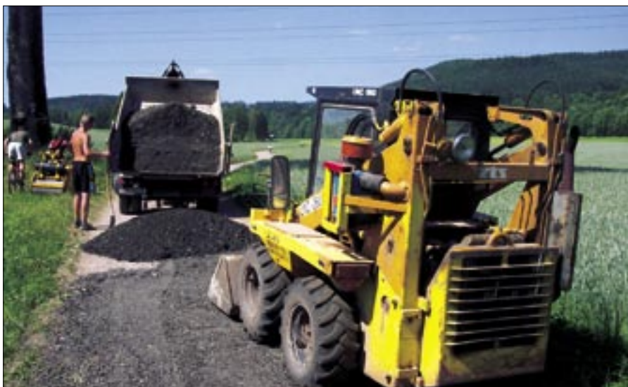
Zpevňování cesty asfaltovou drtí za rybníkem Jindra
