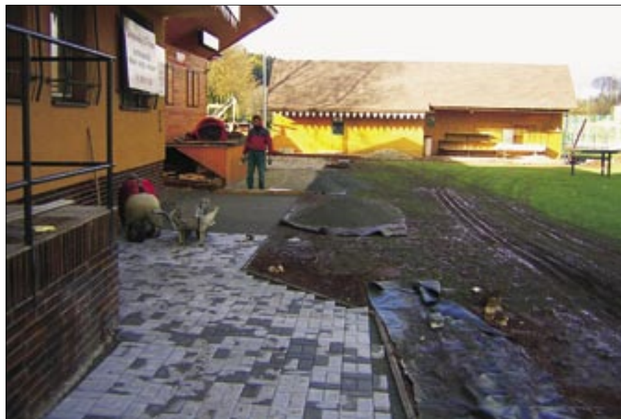
Pokládka zámkové dlažby před hlavní budovou TJ Sokol
