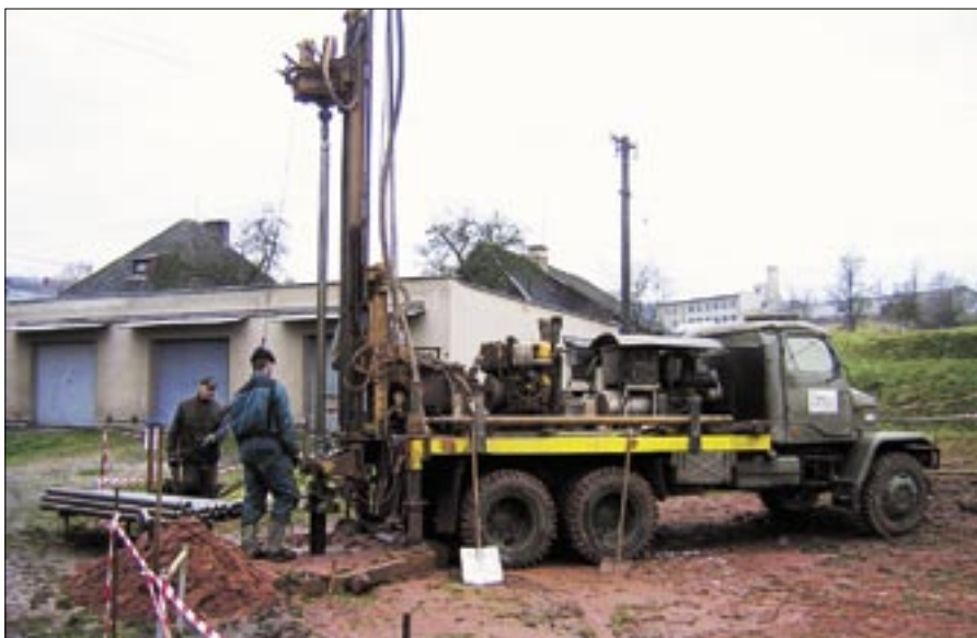
Vrty pro tepelné čerpadlo za Kulturním domem
