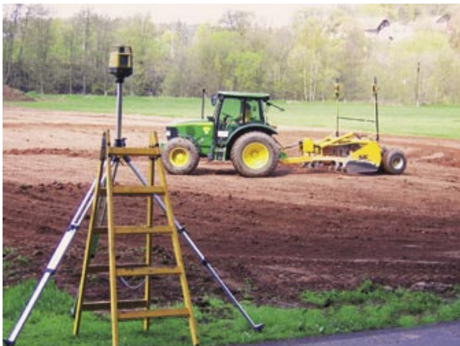
Rovnění terénu pro nové travnaté hřiště
