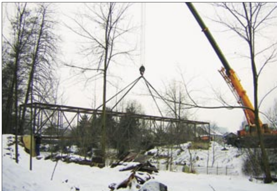
Pokládka mostu Krále Václava přes Úpu
