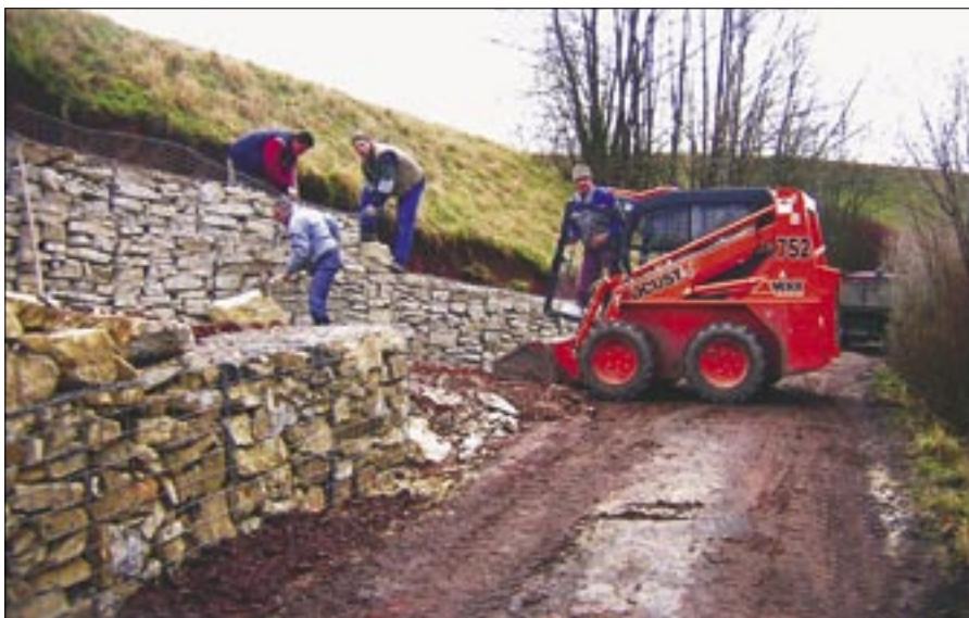
Rozšiřování cesty pomocí gabionů v Kobylinci
