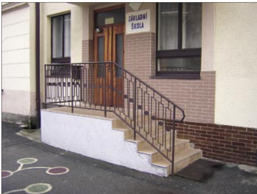
Opravené vstupní schodiště do základní školy
