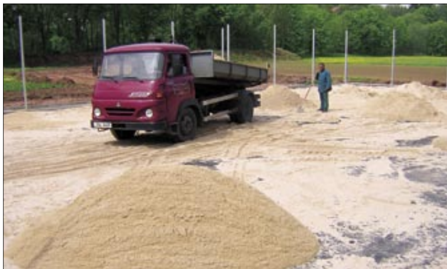
Výstavba hřiště na plážový volejbal
