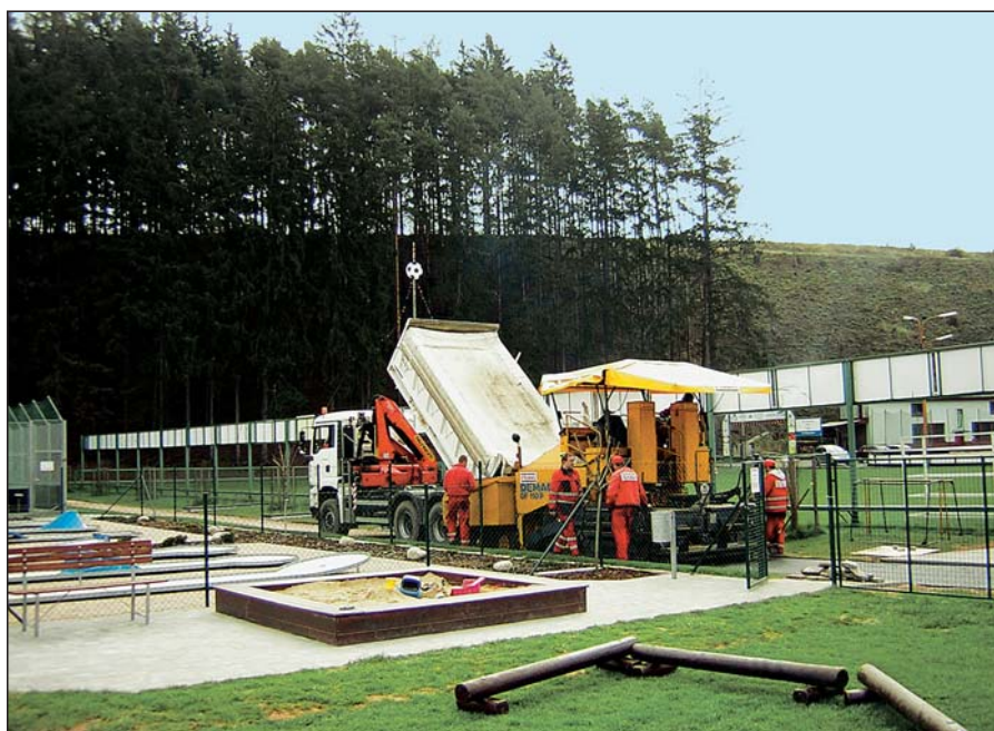
Nová asfaltová komunikace ve sportovním areálu
