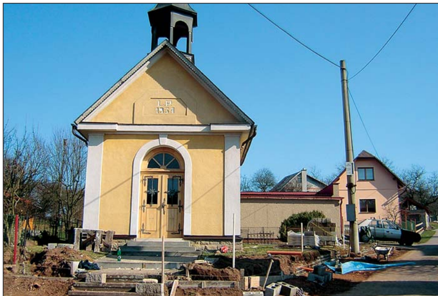
Výstavba nového plotu u kaple sv. J. Nepomuckého
