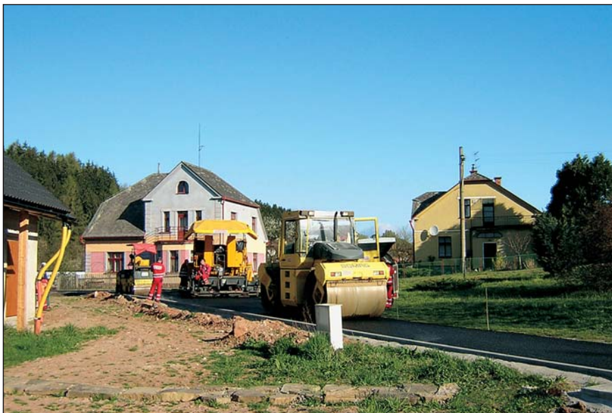
Úprava asfaltové komunikace na Malé Straně
