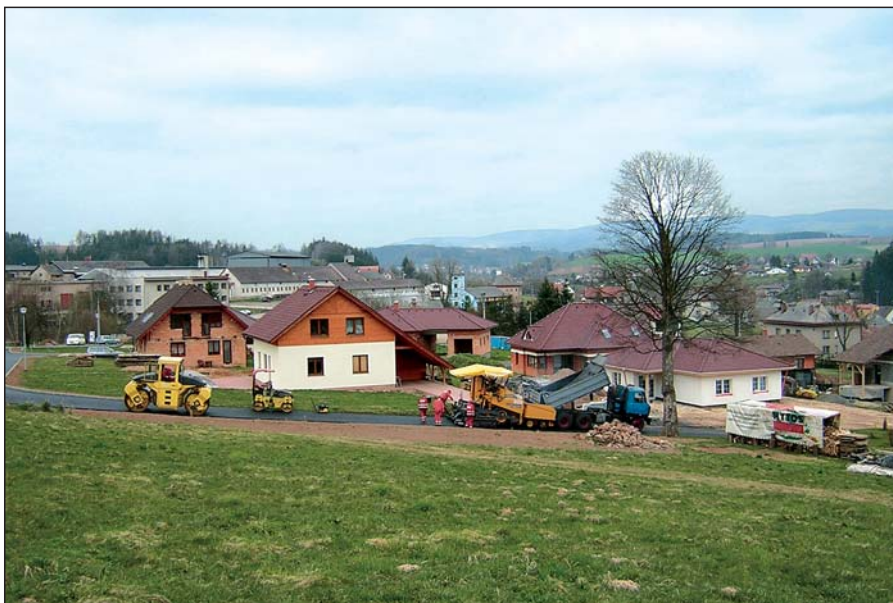
Nová asfaltová komunikace na Králově kopci
