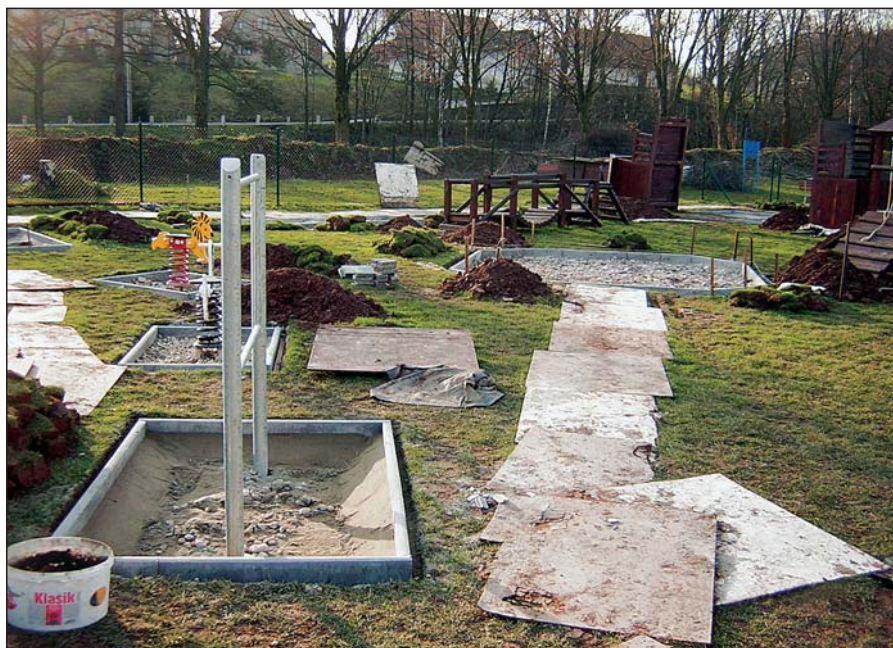
Budování zpevněných ploch pod atrakcemi na dětském hřišti
