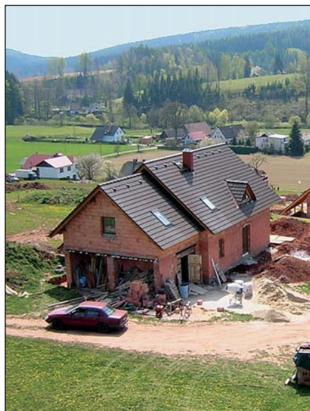
Výstavba nových domů U Zvoničky
