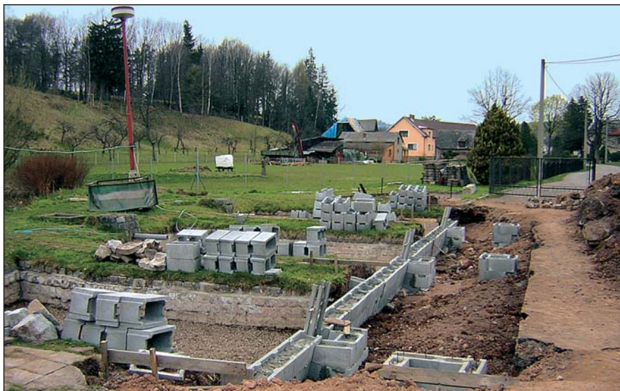
Oprava sádek v areálu ČRS v Havlovicích u rybníka Jindra
