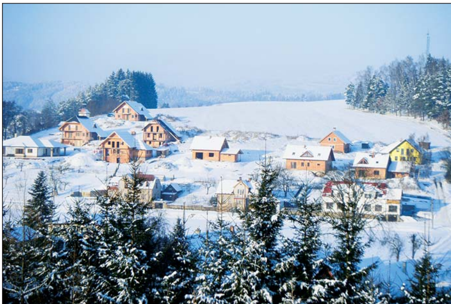
Výstavba nových domů U Zvoničky pokračovala i v roce 2008
