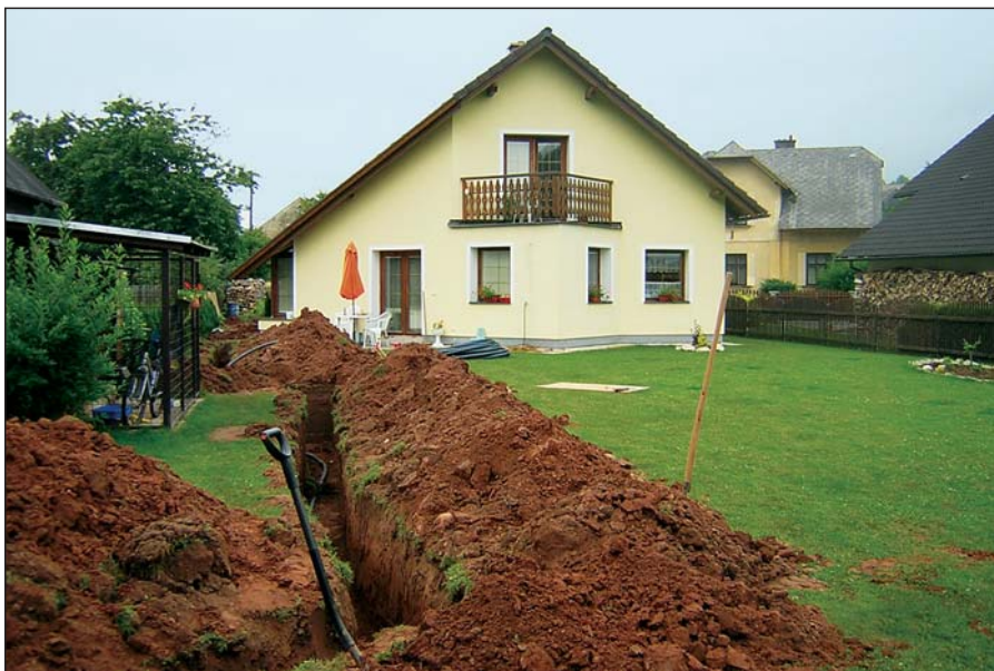
Výměna trubního řadu obecního vodovodu u Zimů na Spořilově
