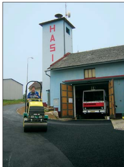
Nová asfaltová komunikace k hasičské zbrojnici
