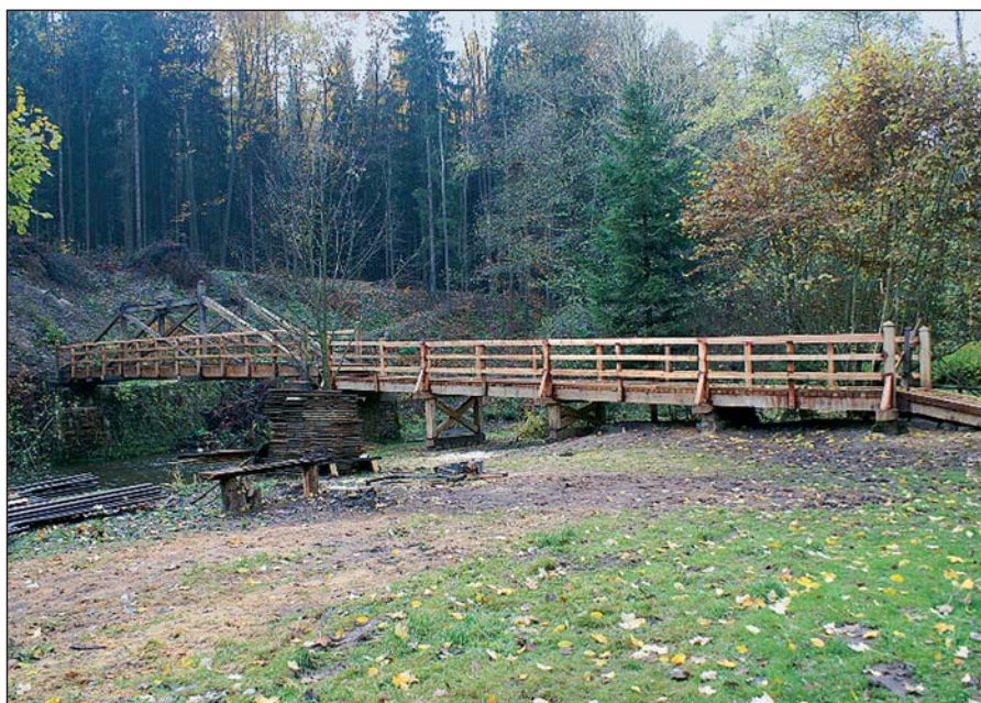
Nová Boušínská lávka – říjen 2008
