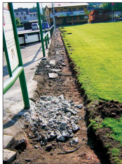
Budování chodníku podél kluziště
