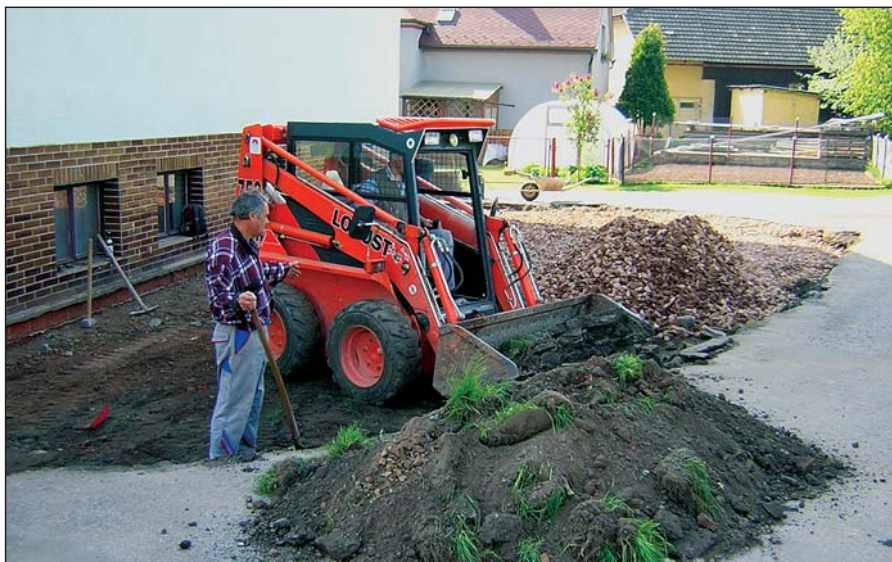
Budování zpevněné plochy za kulturním domem
