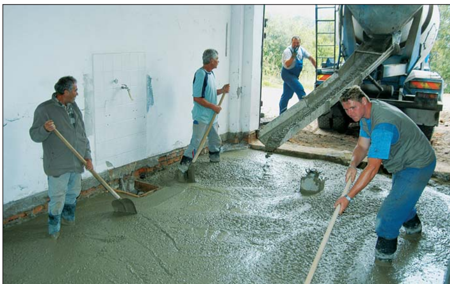
Práce na nové podlaze v hasičárně
