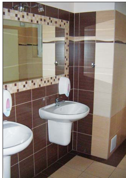
Zrekonstruované WC v kulturním domě
