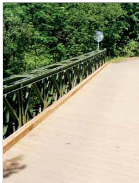
Nová dřevěná mostovka mostu v Náchodci
