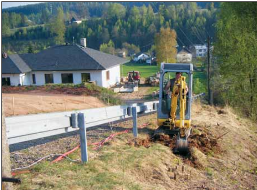
Bagrování rýhy pro kabely NN, veřejného osvětlení a rozhlasu nad skálou U Zvoničky
