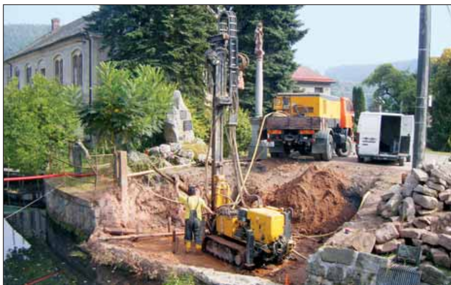
Vrtání mikropilotů na stavbě mostu U Mandle
