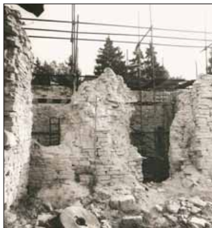
Část východního nádvoří hradu Vizmburku před opravou
