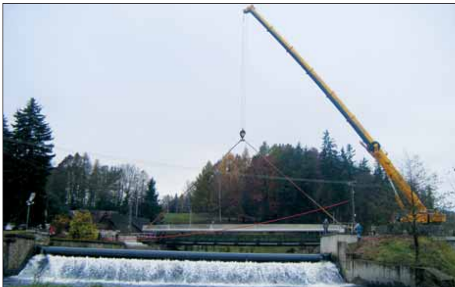
Pokládka betonových nosníků
