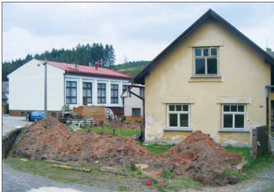
Rekonstrukce vodovodního potrubí za kulturním domem
