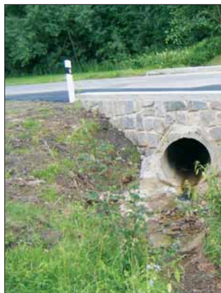
Opravený mostek na místní komunikaci v
