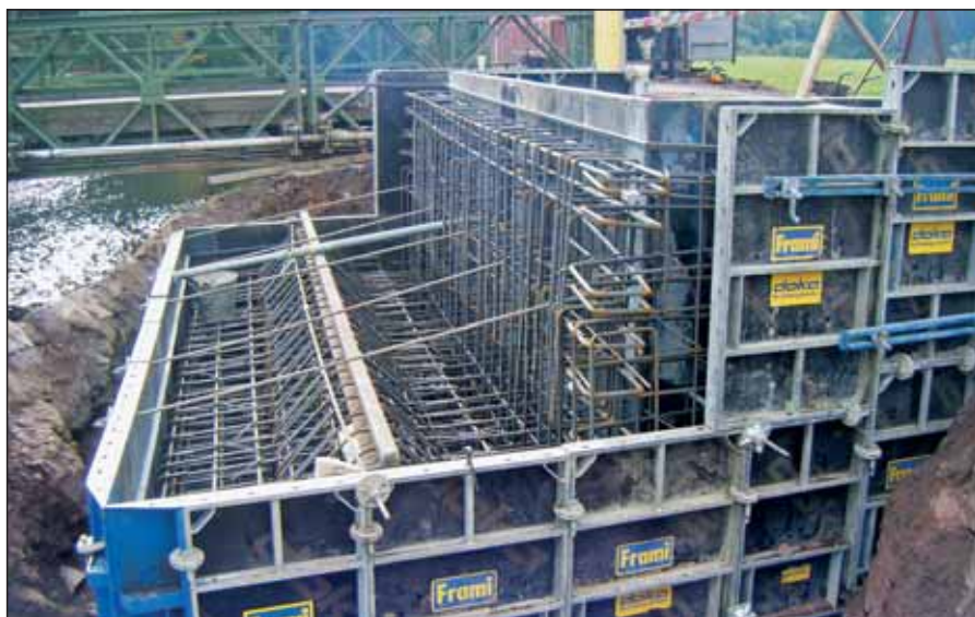
Budoucí levobřežní mostní podpěra před betonáží
