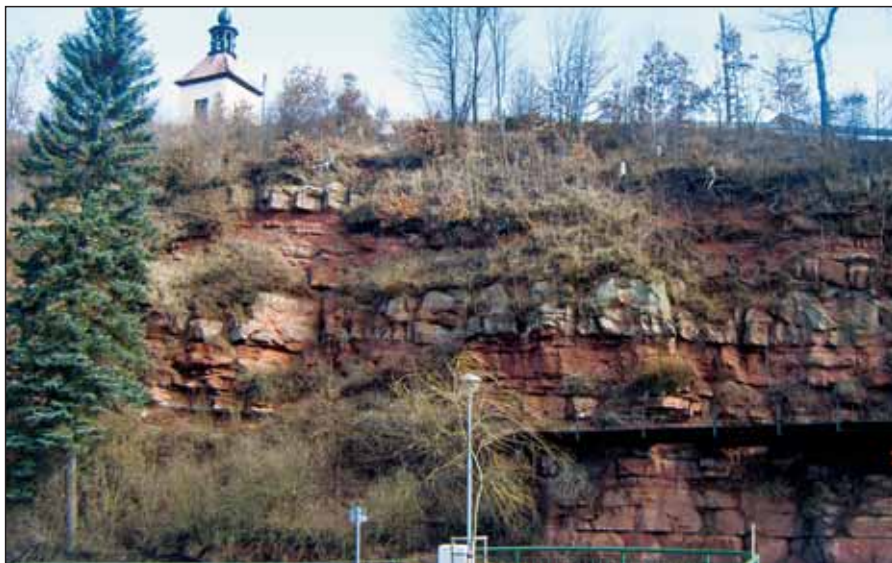
Pohled na skalní masiv nad místní komunikací před zahájením prací
