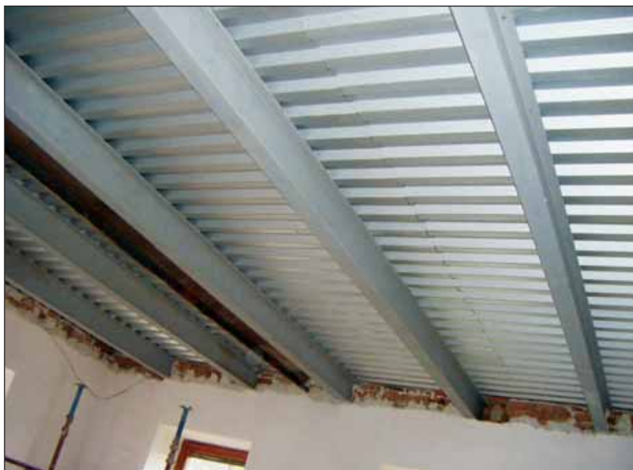
Pohled na novou stropní konstrukci ze třídy
