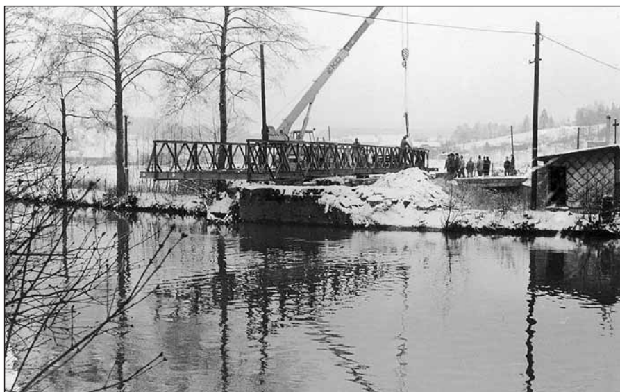
Stavba železného mostu Bailey bridge 15. 12. 1979
