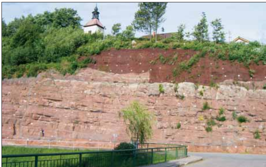
Skalní masiv po ukončení sanačních prací
