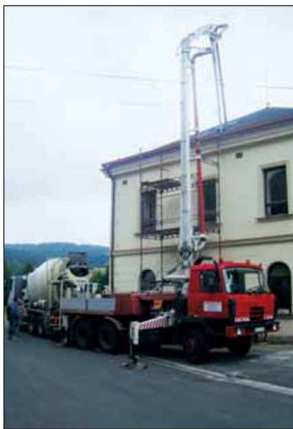
Betonování stropů nad třídami v základní škole
