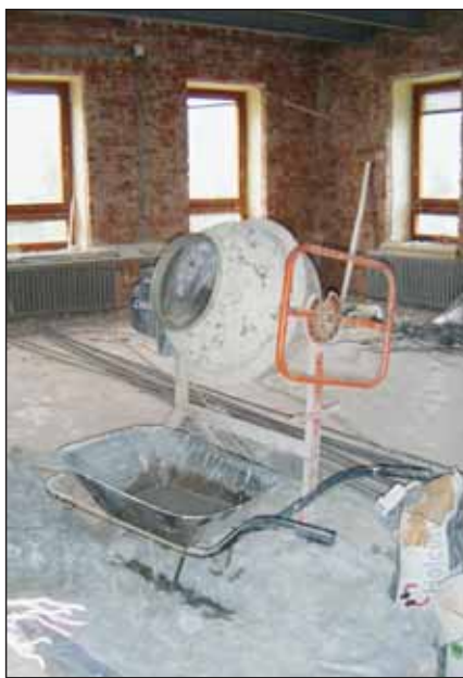
Při výměně stropů byly ve třídách základní školy provedeny i nové vnitřní omítky
