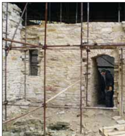
Východní nádvoří po opravě provedené v roce 2009 firmou Rehis
