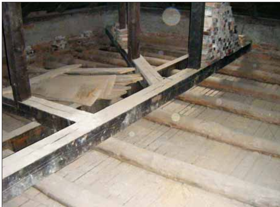
Původní stropní konstrukce nad třídami v základní škole z roku 1880
