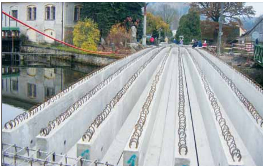
Všech 8 kusů betonových nosníků je už na svém místě
