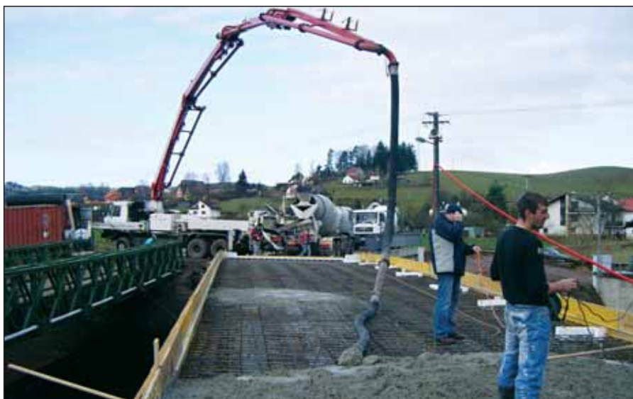
Betonáž spřažené železobetonové desky o tloušťce 200 mm na novém mostě
