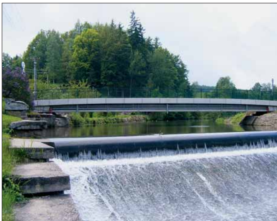
Nový betonový most přes řeku Úpu U Mandle
