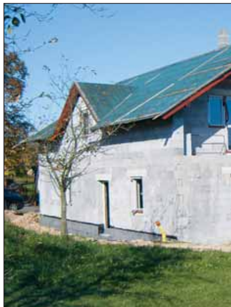
Nový dům budovaný pod areálem Zemědělské
