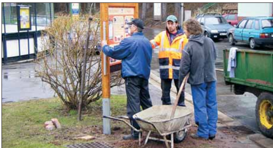
Betonování jedné z informačních tabulí naučného okruhu „U Nás“ u školy
