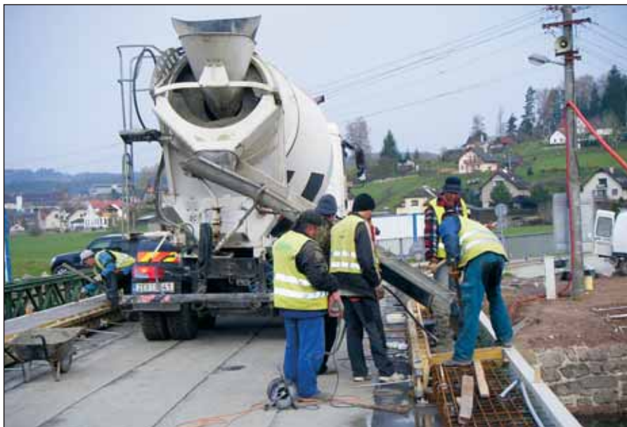
Betonování chodníků nového mostu U Mandle
