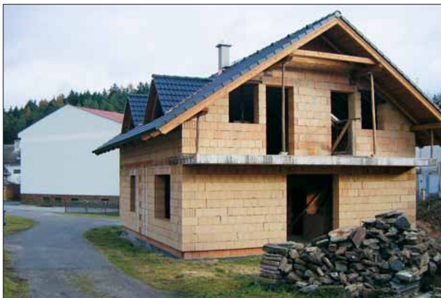
Novostavba rodinného domu za kulturním domem
