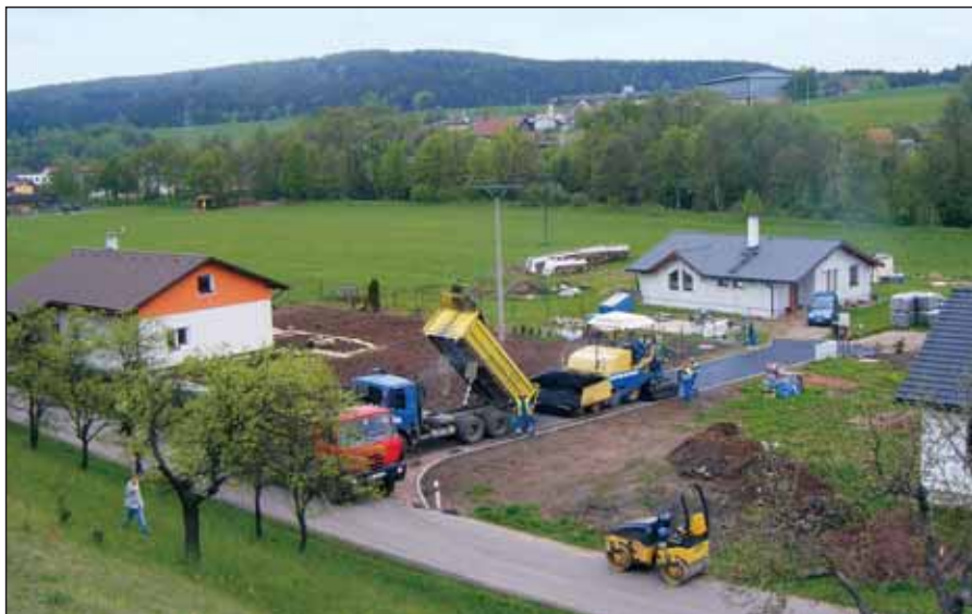
Pokládka asfaltového povrchu v nové zástavbě na Malé Straně
