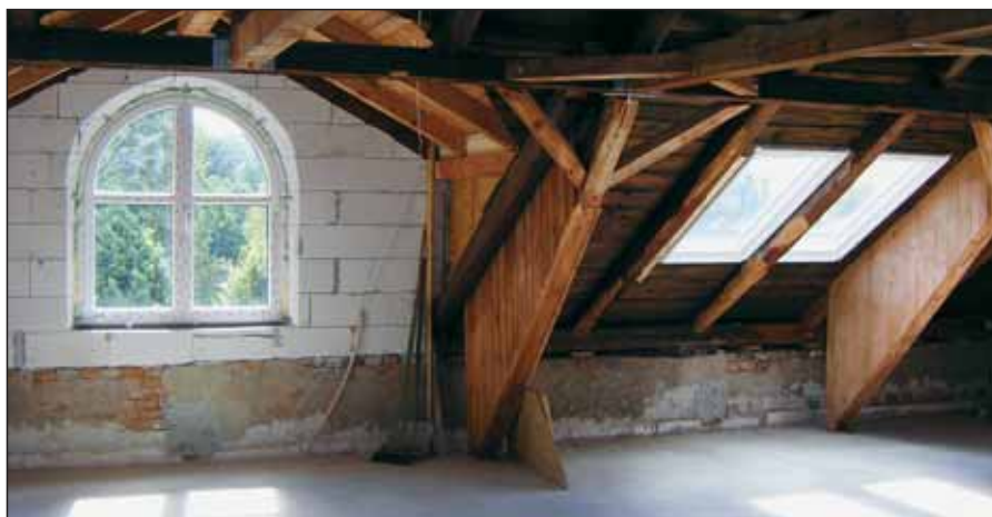
Úprava půdních prostor v základní škole včetně nového vikýře a střešních oken
