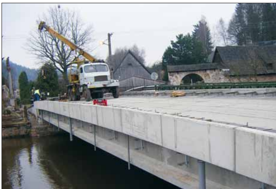
V březnu byly po zimní přestávce zahájeny práce na dokončení stavby mostu U Mandle
