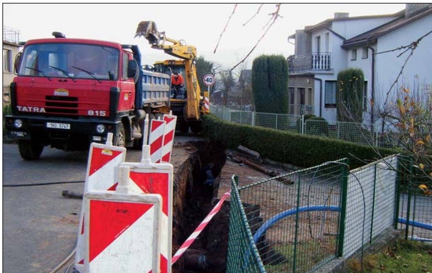
Výměna vodovodního potrubí u kapličky
