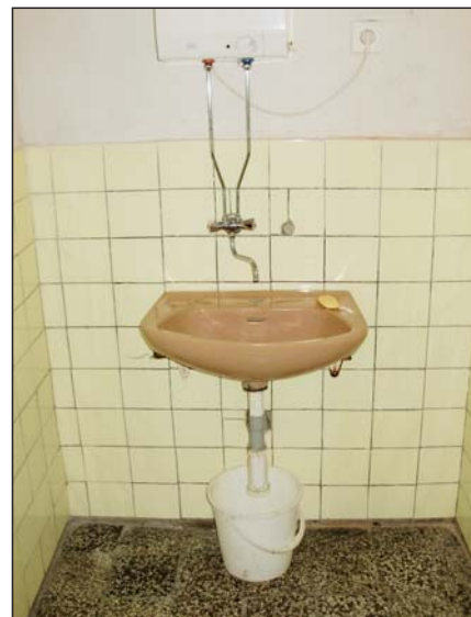
Umyvárka v tělocvičně před rekonstrukcí
