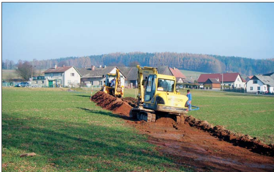
Výměna vodovodního potrubí na Popluží
