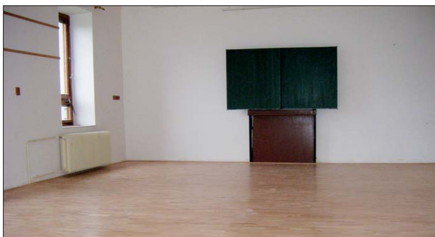
Přebroušené a nově nalakované parkety v základní škole
