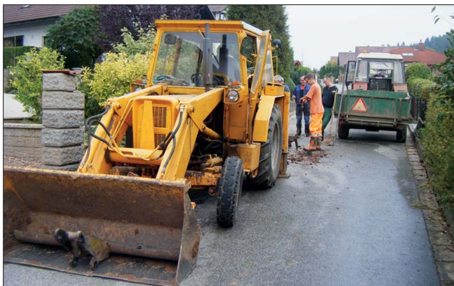
Oprava vodovodu na Výsluní
