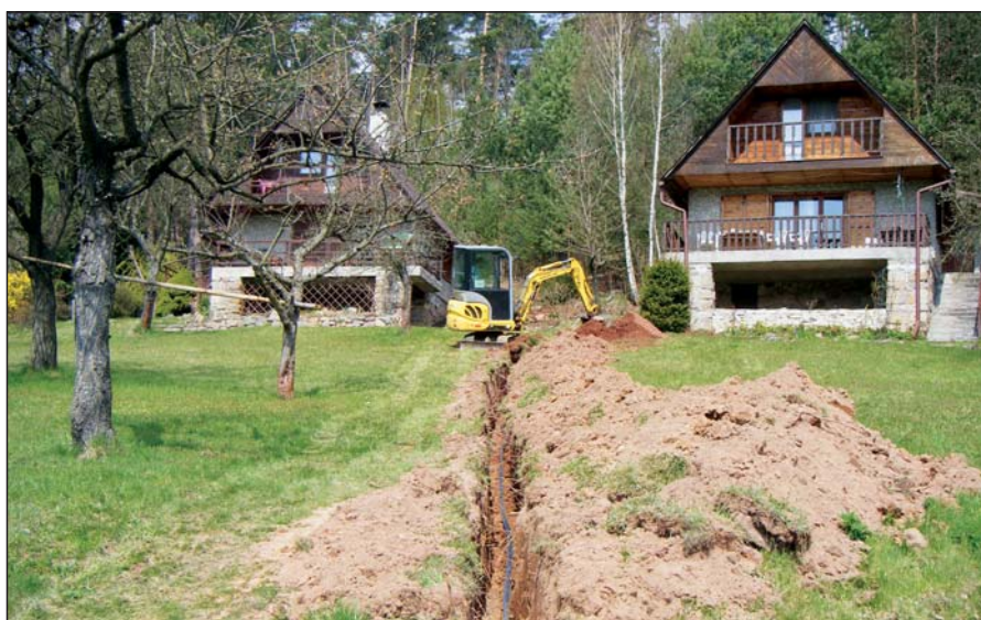
Výměna trubního řádu obecního vodovodu v Dolečkách
