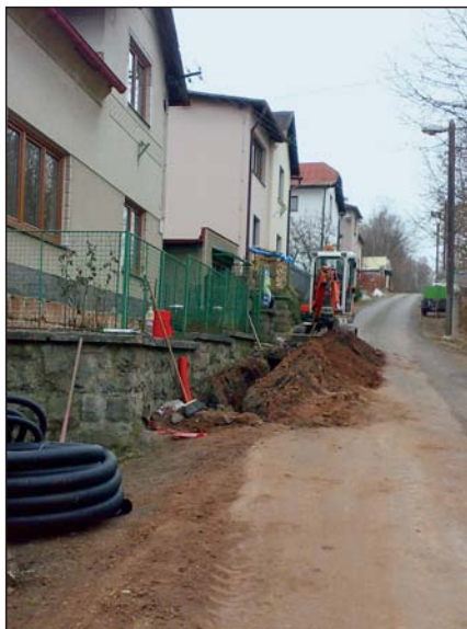
Pokládka kabelového vedení v ulici Nad Jutou
