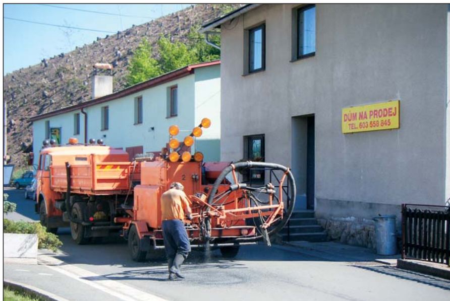
Oprava komunikací penetračním nástřikem
