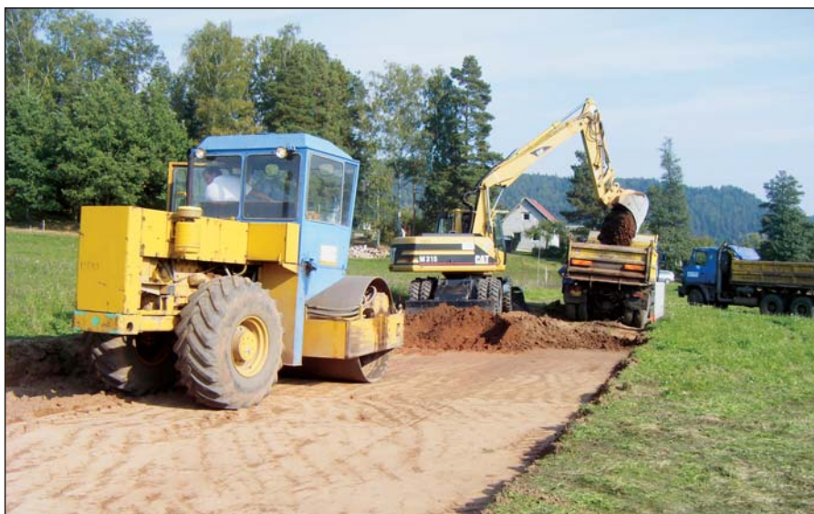
Budování štěrkové komunikace k novým stavebním parcelám U Zvoničky
