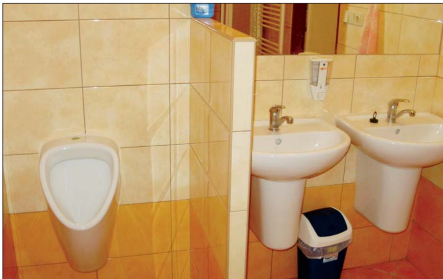
Nové záchody a umyvadla v tělocvičně
