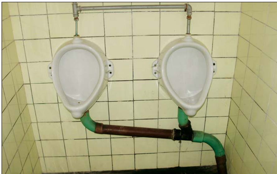
Záchody v tělocvičně před rekonstrukcí
