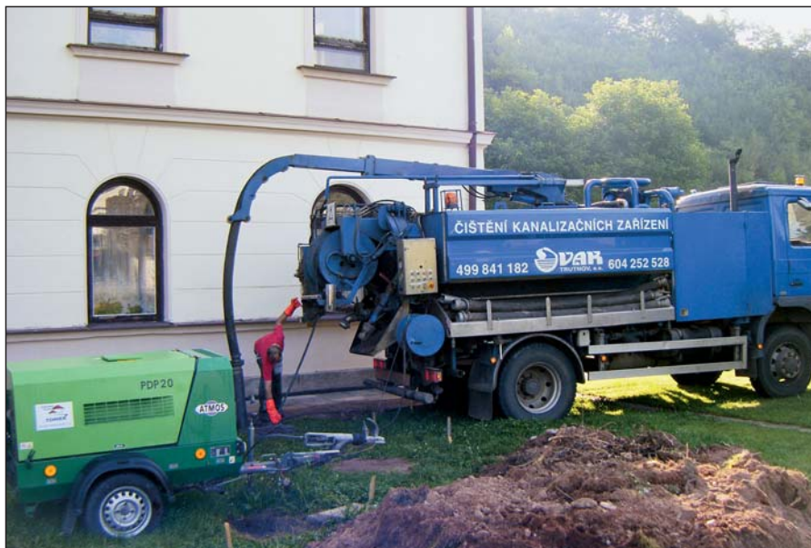
Čištění kanalizace před školou
