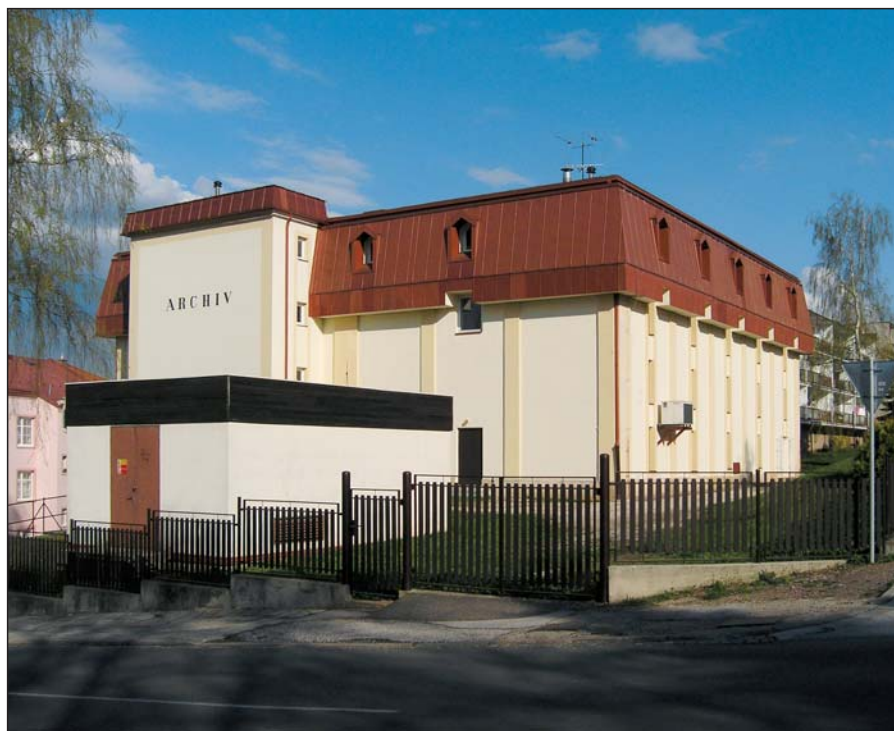
Budova Státního okresního archivu v Trutnově
