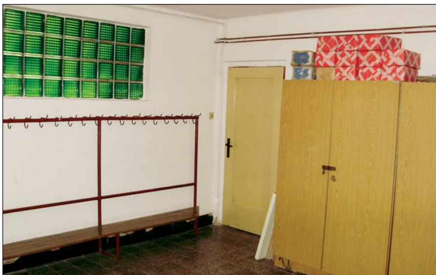
Původní šatna v tělocvičně
