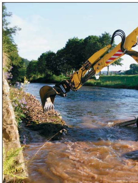
Před opravou kamenné regulace bylo nutné
