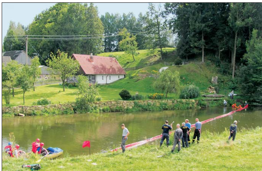
Cvičení na pokládku norné stěny na řece Úpě U Mandle
