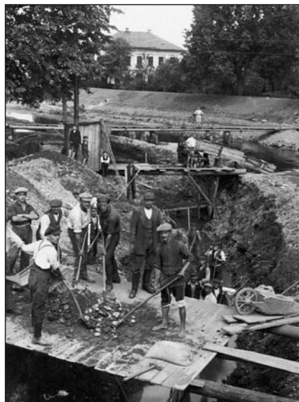
Stavba regulace řeky Úpy probíhala v letech 1924–1927
