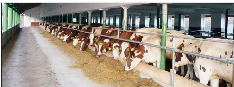
Kravín KII prošel rozsáhlou rekonstrukcí
