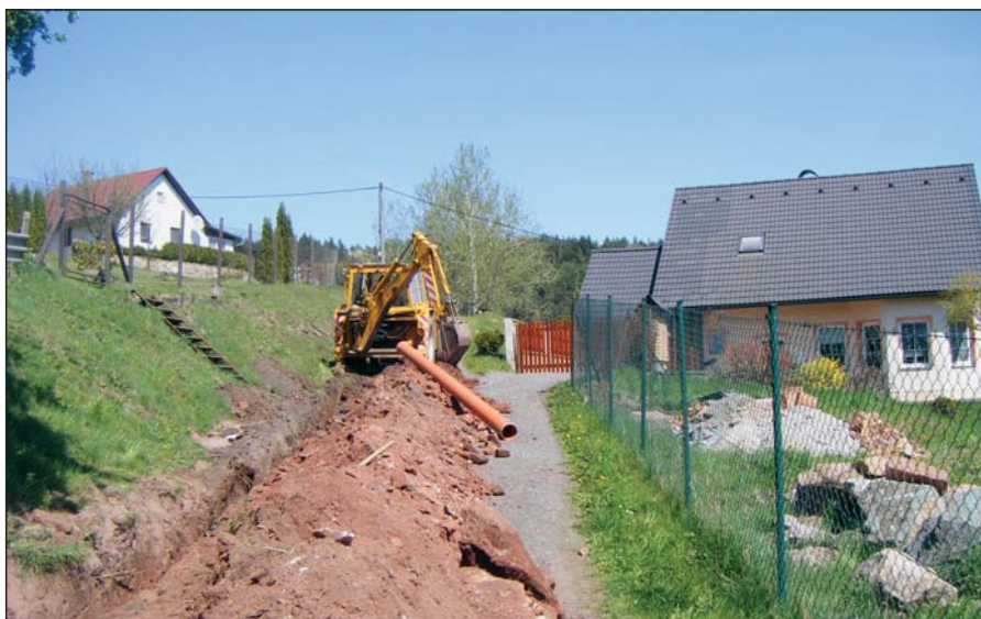
Budování kanalizace na Podhájí
