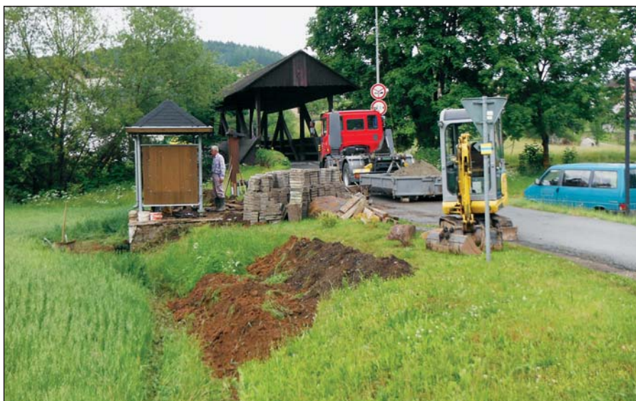
Oprava opěrné zdi a zámkové dlažby u autobusové zastávky
