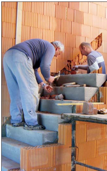
Brigáda na vybudování schodiště v nových garážích
