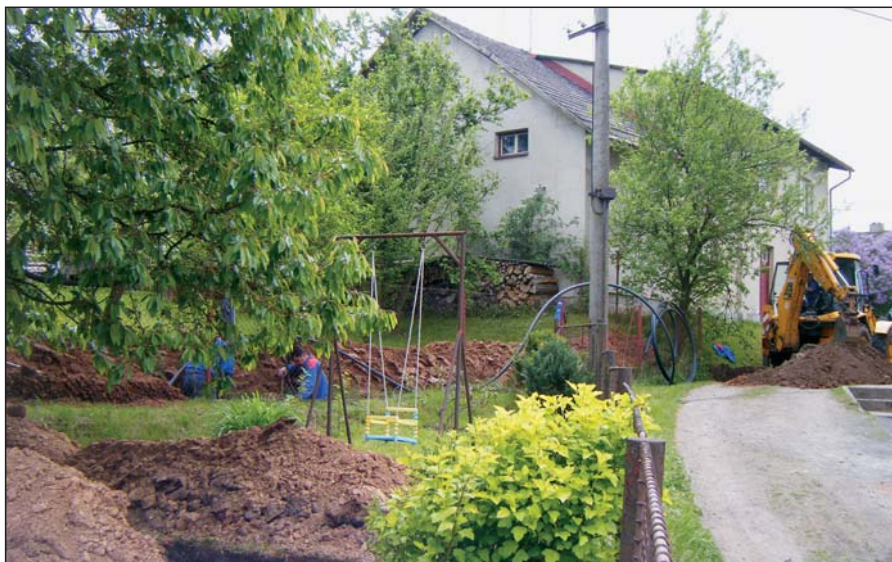
Výměna vodovodního potrubí na Hořejším konci obce
