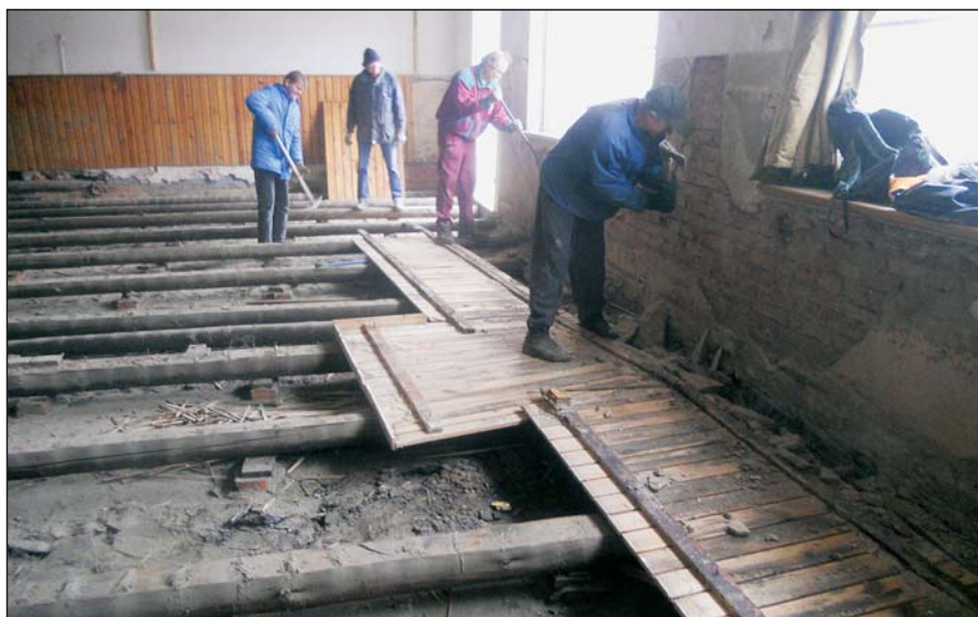
Brigáda na rekonstrukci tělocvičny
