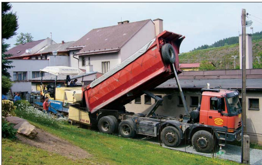
Asfaltový koberec byl položen i za obecním úřadem směrem k tělocvičně
