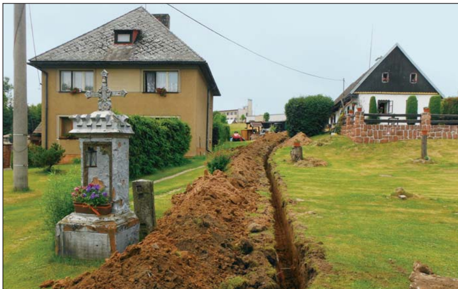
Nová vodovodní přípojka k domu č.p. 172
