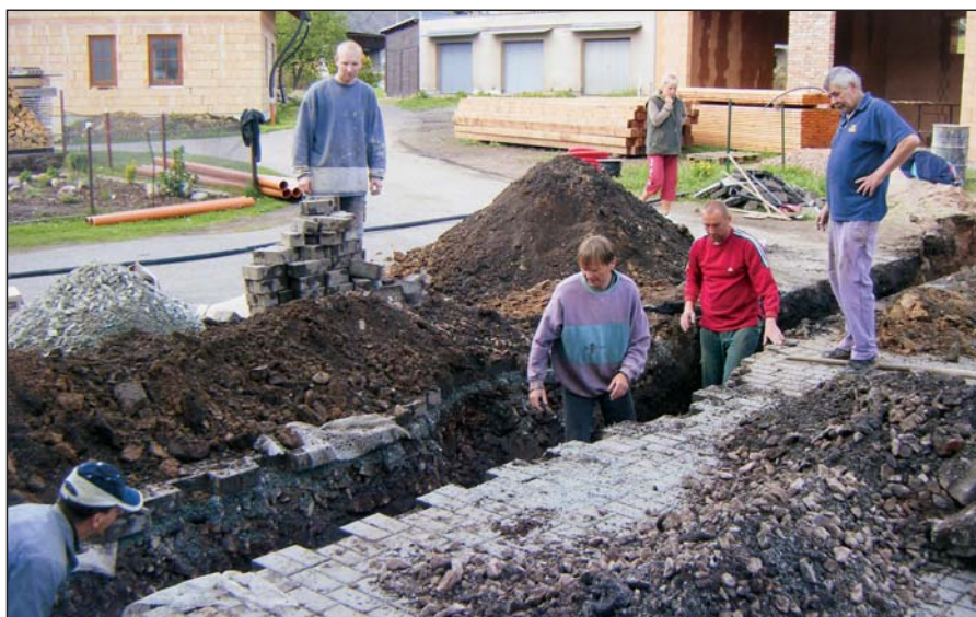
Pokládka potrubí z kulturního domu do nových garážích za účelem vytápění
