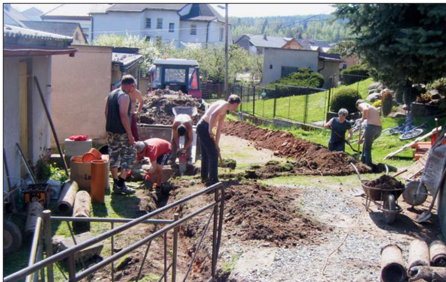
Brigáda na prodloužení veřejného osvětlení a na opravě kanalizace za obecním úřadem
