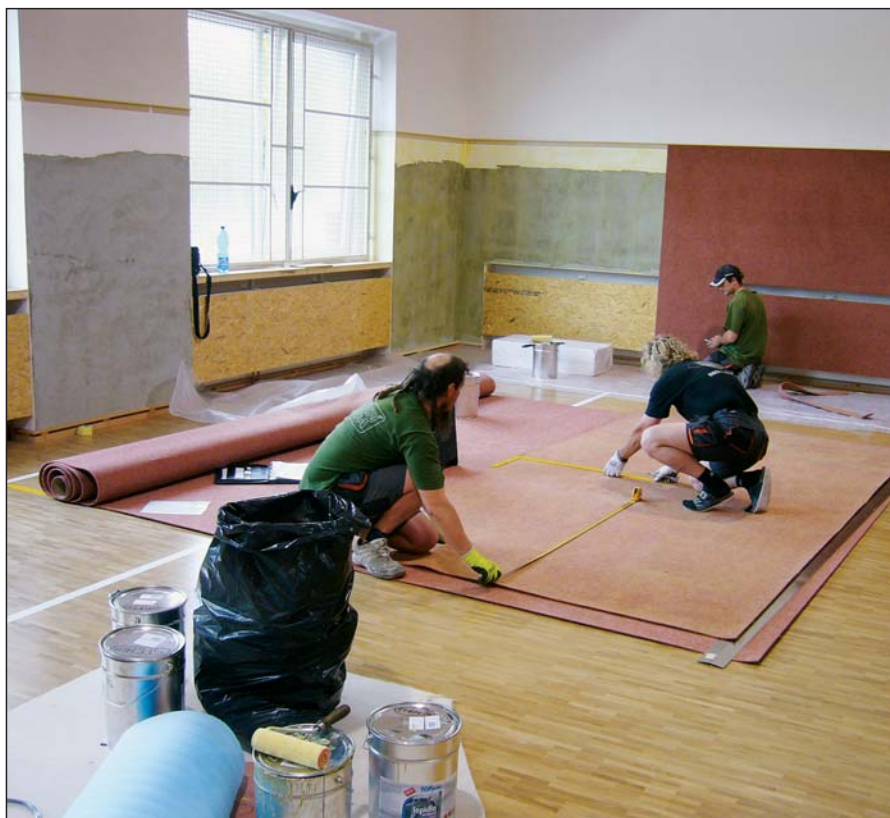
Lepení zátěžového koberce v opravené tělocvičně
