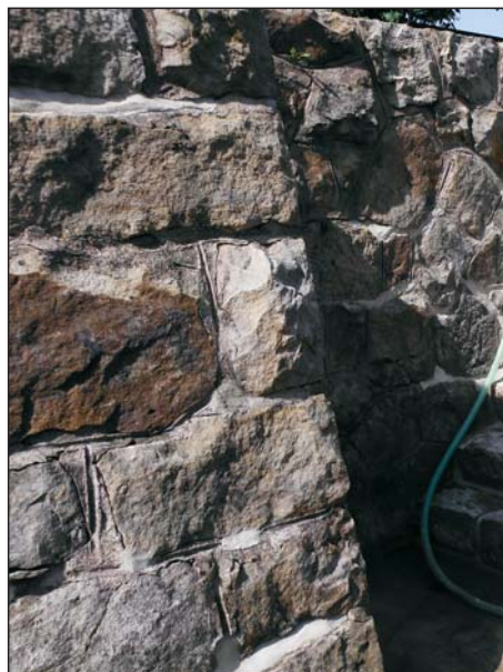
Opravené původní schody do řeky Úpy
