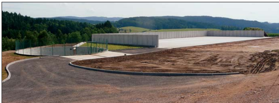
Celkový pohled na nové polní hnojiště
