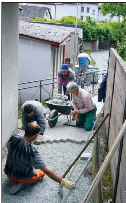
Svépomocí bylo provedeno odvodnění a položení zámkové dlažby na chodníku k tělocvičně
