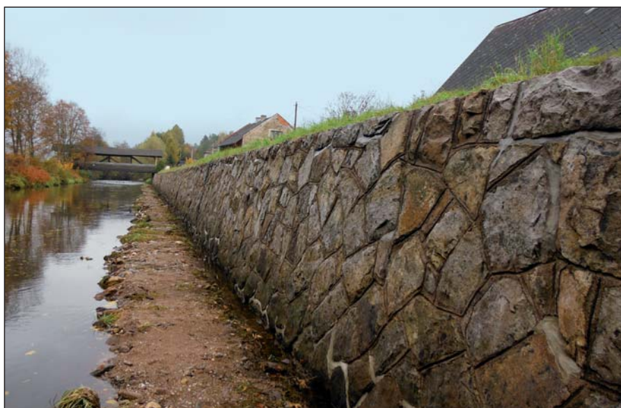
Kamenná regulace podél řeky Úpy se dočkala opravy.
