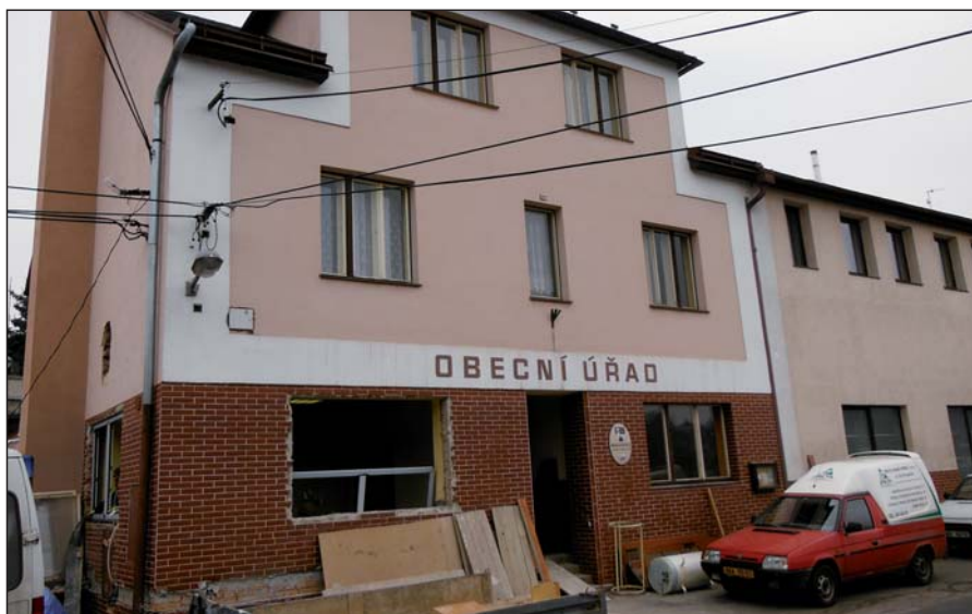
Původní okna byla nahrazena plastovými s izolačním trojsklem
