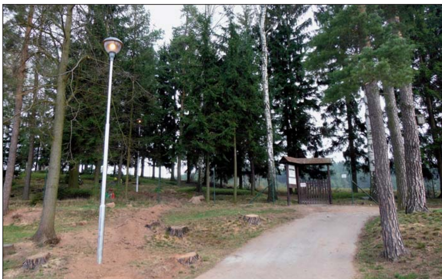
Nové veřejné osvětlení u urnového háje
