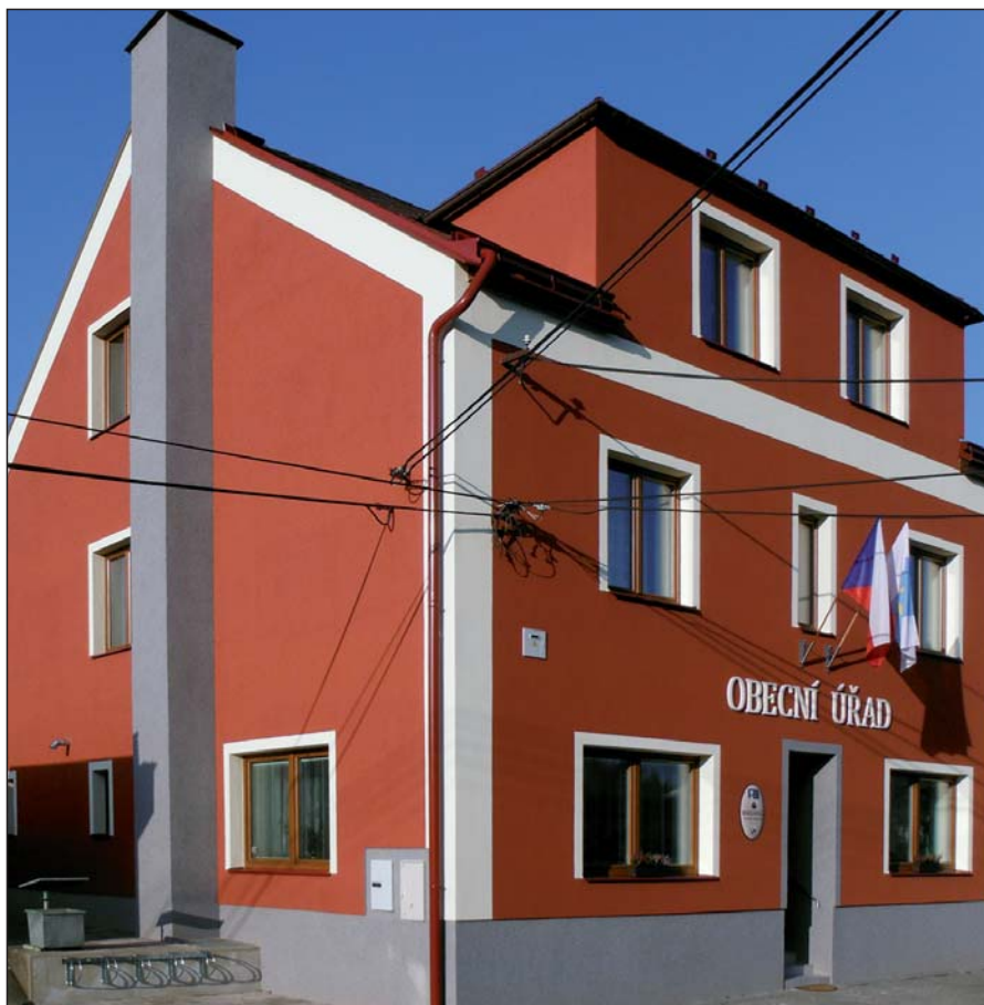
Budova obecního úřadu po celkové rekonstrukci
