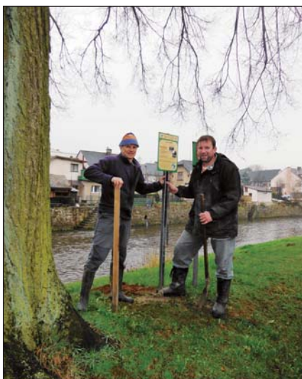
Betonování sloupků u významných stromů s informačními cedulemi
