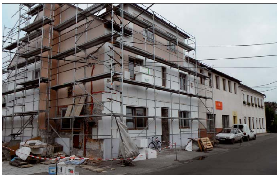
Zateplování venkovní fasády polystyrénem
