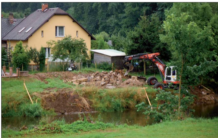
Zpevňování břehů poškozených povodní na Závodi
