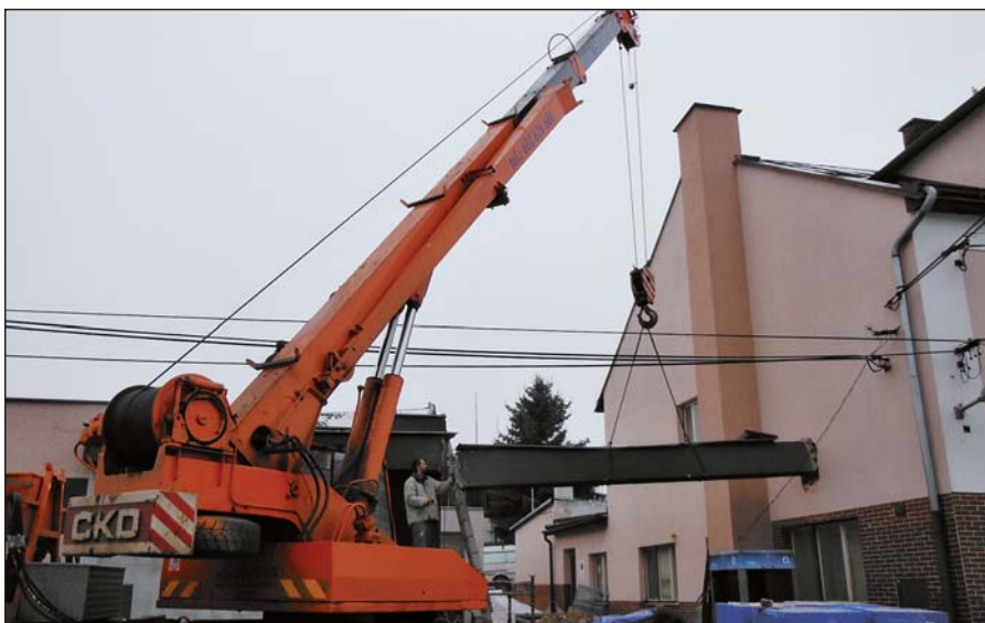
Odstraňování betonového překladu spojujícího obecní úřad s prodejnou
