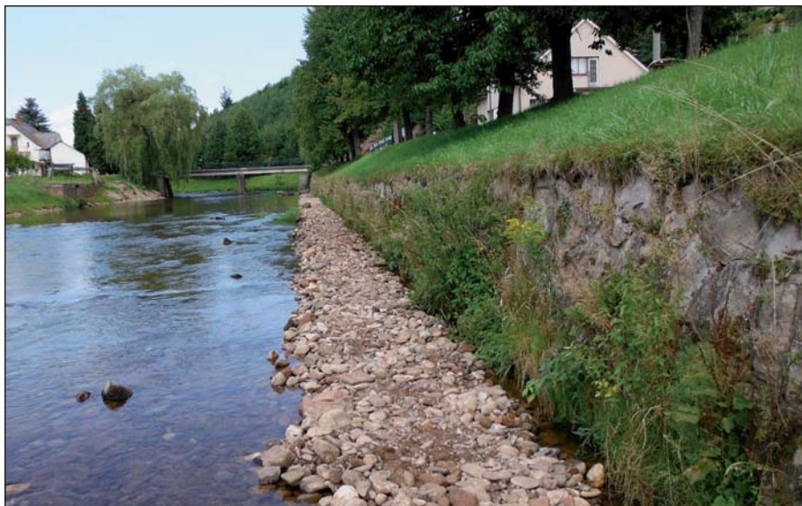
Pomocná hrázka při opravě kamenné regulace
