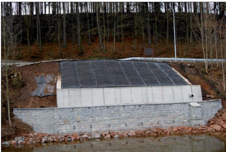
Opravený svah podél hlavní silnice v Habříně
