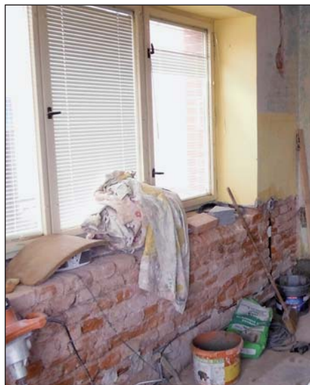
Bylo nutné opravit vnitřní omítky ve všech
