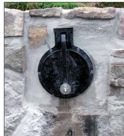
Na vyústění kanalizace do řeky Úpy byly osazeny další zpětné klapky
