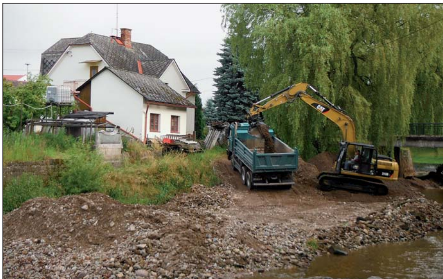
Bagrování náplavů pod betonovým mostem ve Vsi
