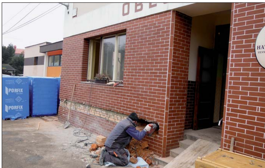
Podsekávání obvodových zdí a vkládání izolace proti zemní vlhkosti
