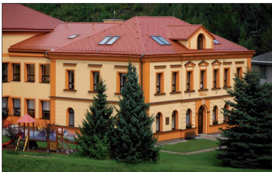
Nová střešní krytina z hliníkového plechu
