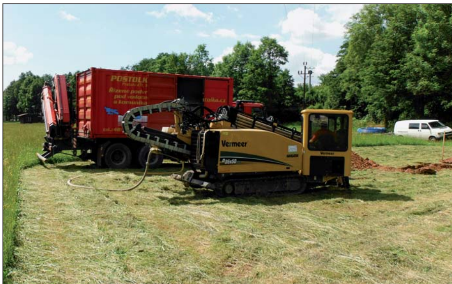
Podvrtávání řeky Úpy na Malé Straně
