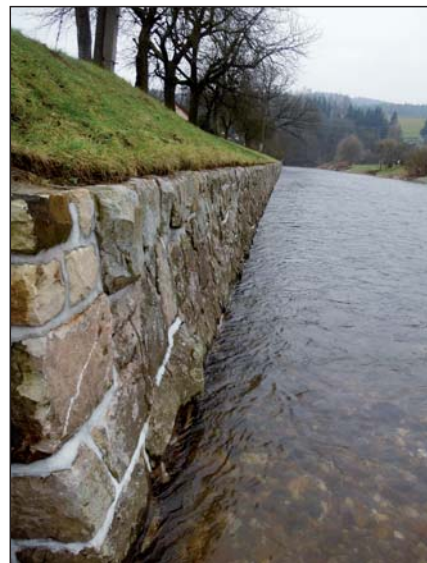
Opravená kamenná regulace směrem k Závodi
