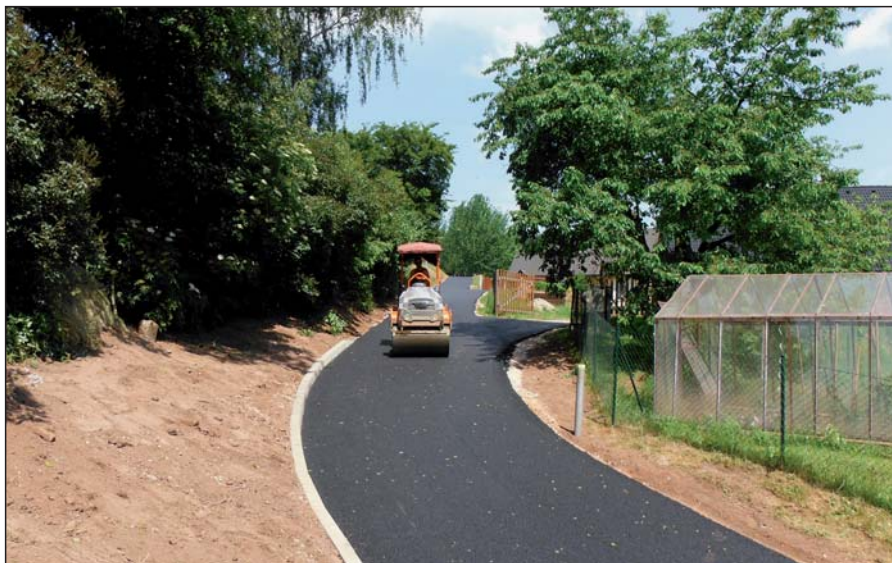
Nová asfaltová komunikace u urnového háje
