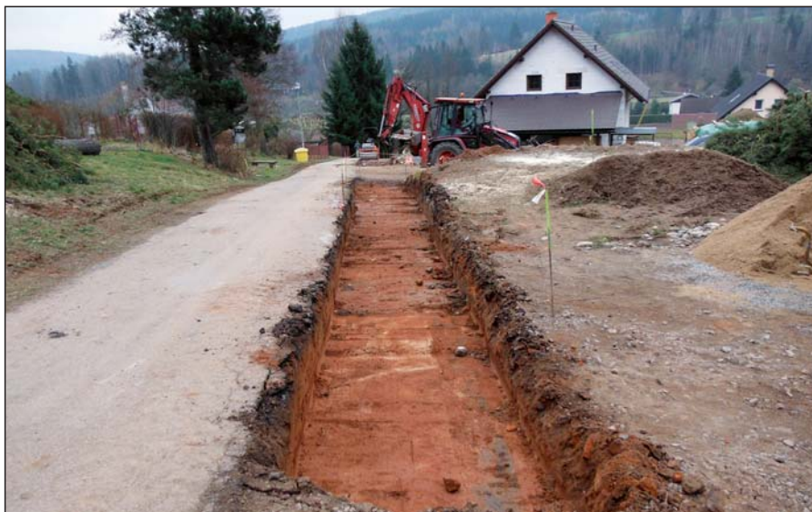
Rozšiřování původní asfaltové komunikace k urnovému háji
