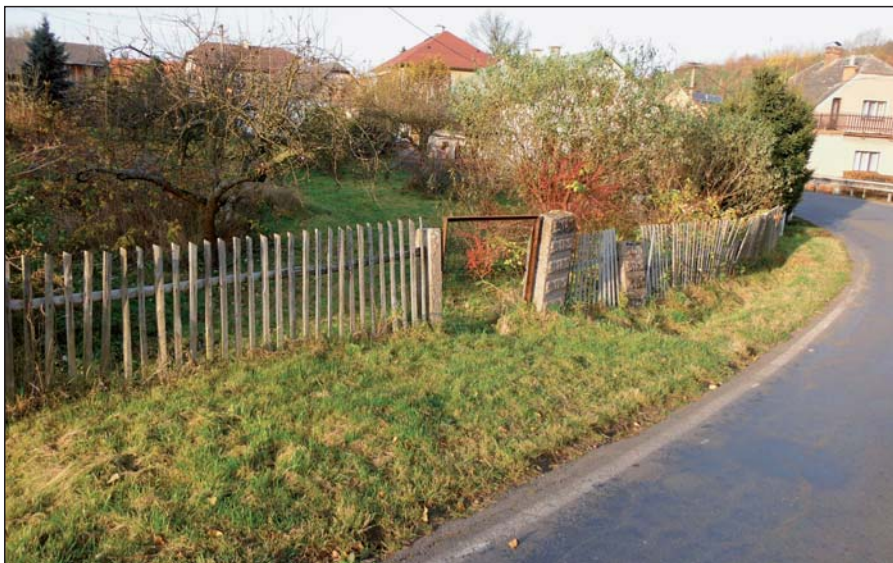
Nepřehledná zatáčka u bytovek před stavbou chodníku
