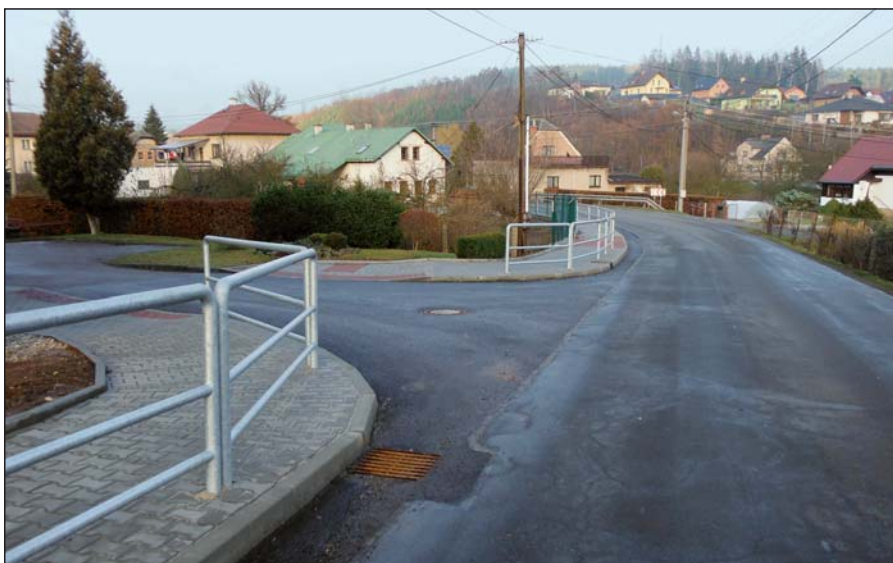
Nový chodník u bytovek
