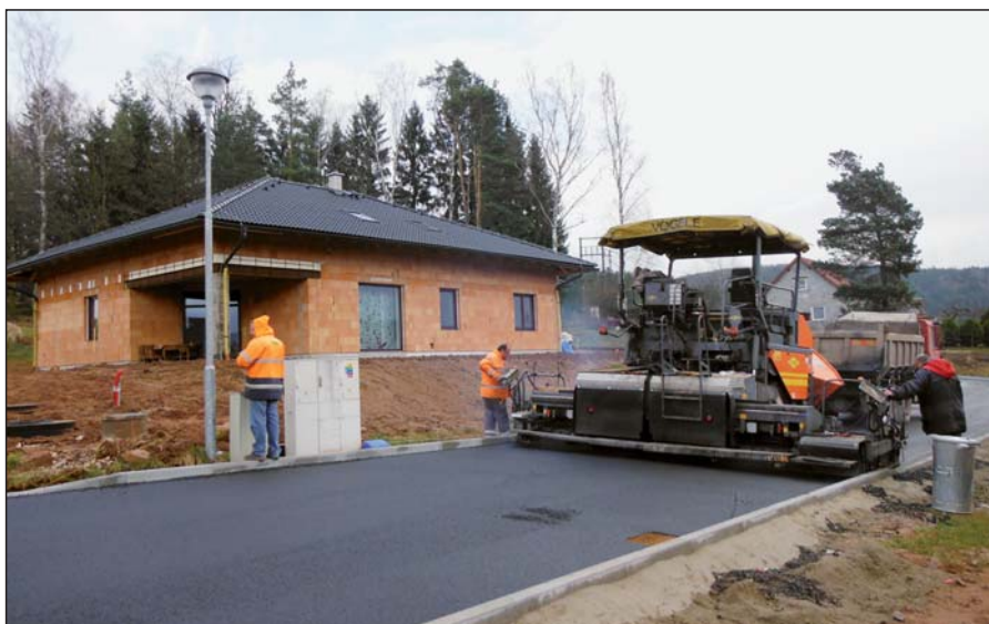
Budování asfaltové komunikace k rodinným domům U Zvoničky
