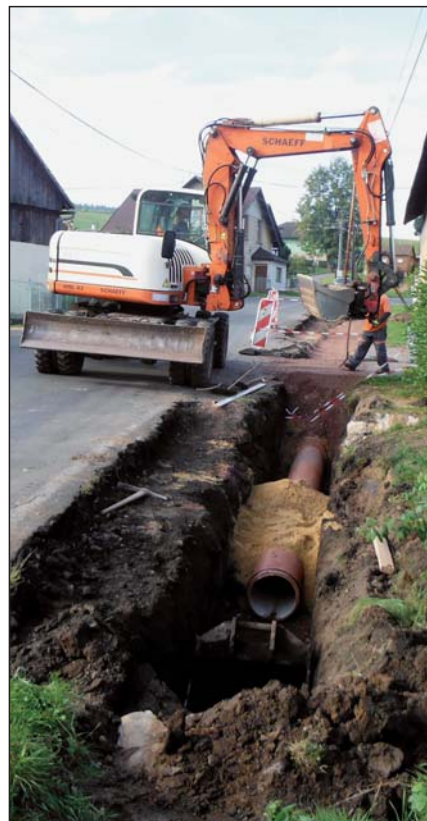
Budování chodníku a dešťové kanalizace u bytovek
