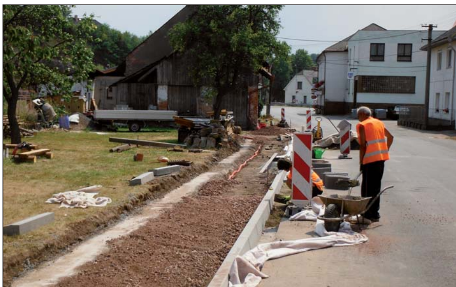
Budování chodníku podél komunikace u obecního úřadu
