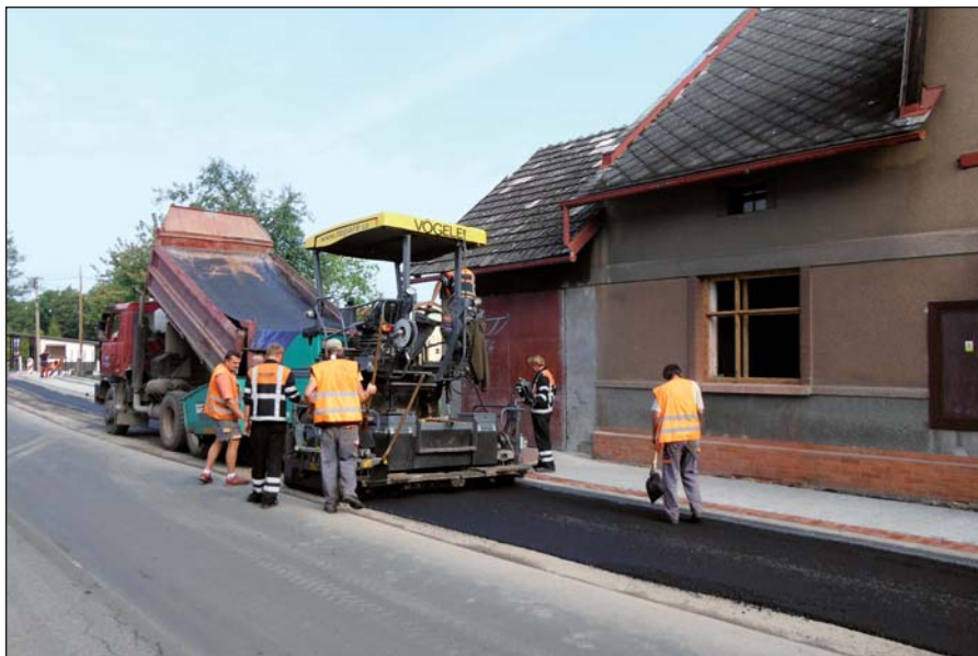
Při budování chodníku byl na přilehlé polovině komunikace položen nový asfaltový kryt
