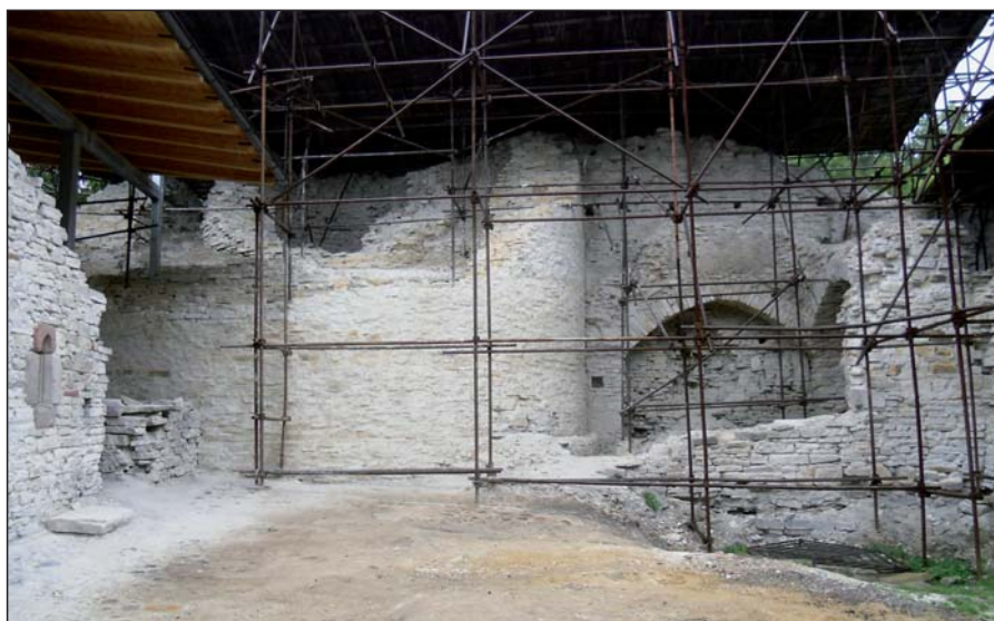
Věž z nádvoří byla vyzděna až do 7 metrů nad kuchyní
