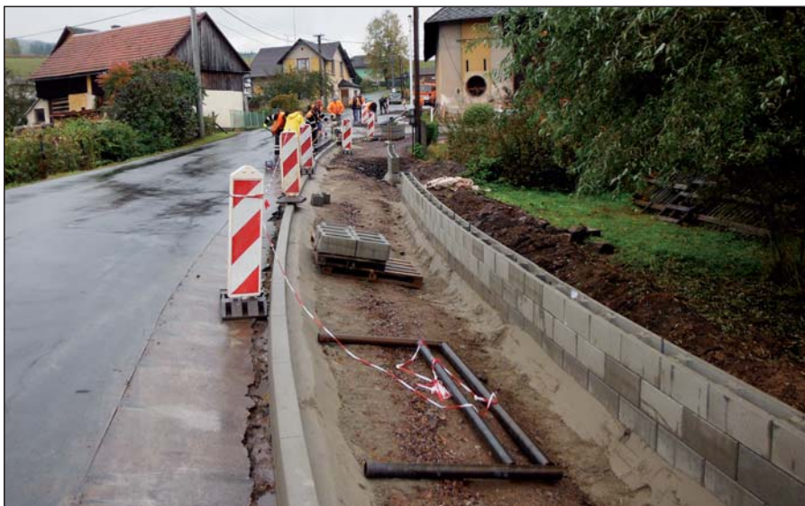
Ze stavby chodníku
