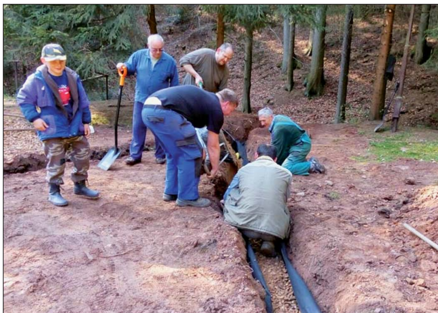
Myslivci při pokládce drenáže na Tylově paloučku
