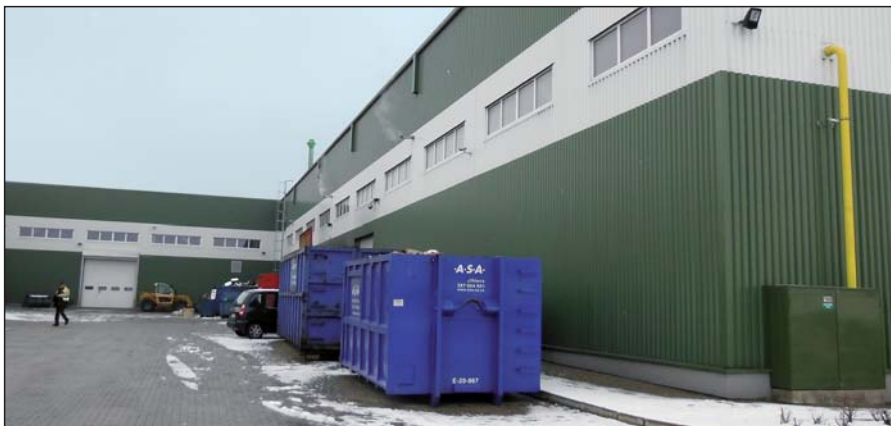
Závod na zpracování elektroodpadu společnosti ENVIROPOL s.r.o. v Jihlavě
