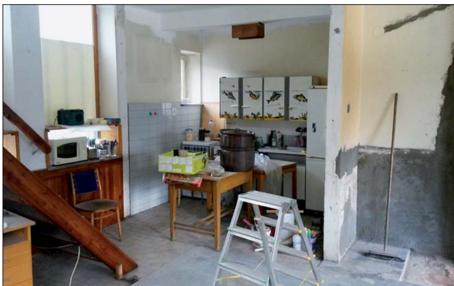
Kuchyň před rekonstrukcí
