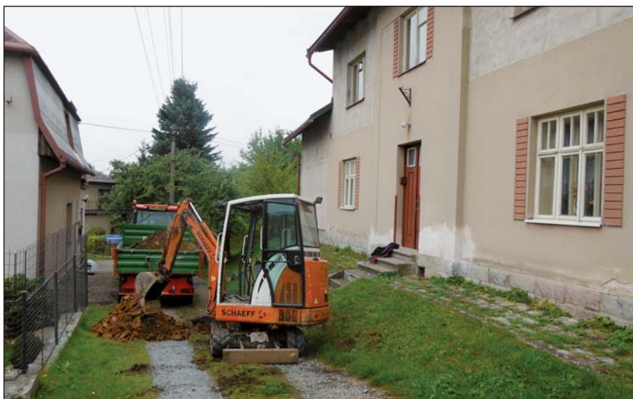
Oprava vodovodního potrubí na Hořejším konci
