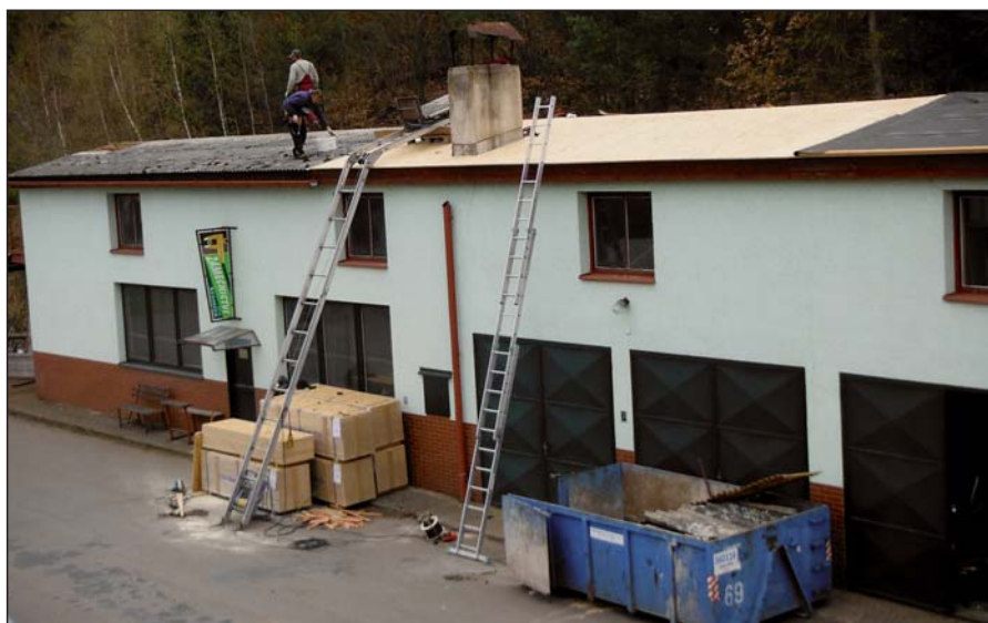
Pokládka nové střešní krytiny na obecních garážích u školy
