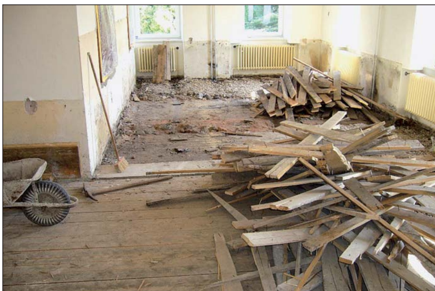
Výměna podlahy ve školní jídelně
