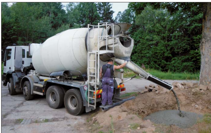
Betonování nových základů
