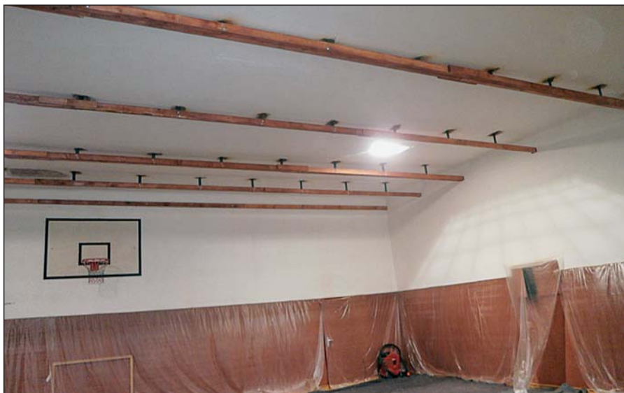
V tělocvičně TJ Sokol byl vyroben stropní podhled
