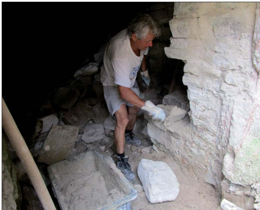
Stavební práce na Vízmurku probíhaly svépomocí
