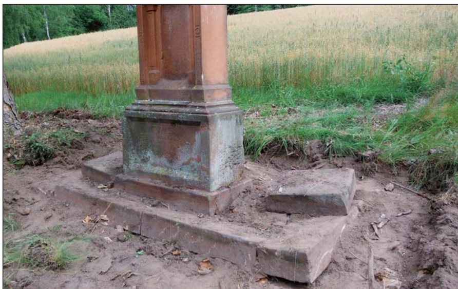
U sousoší byly i značně poškozené základy
