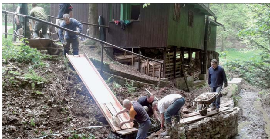
Regulace potoka pod Tylovým paloučkem
