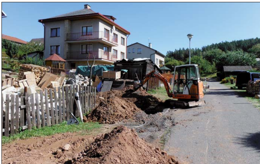
Výměna vodovodního potrubí Na Drahách
