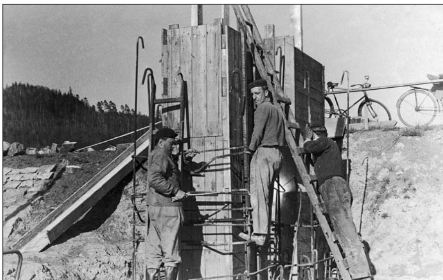
Budování výpustě rybníka Jindra r. 1958
