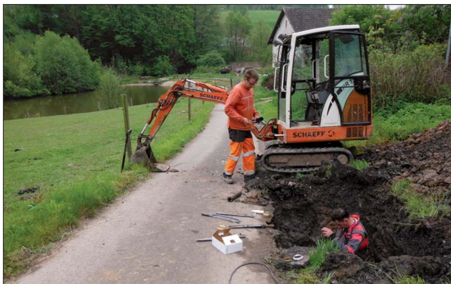
Oprava prasklého potrubí na Popluží
