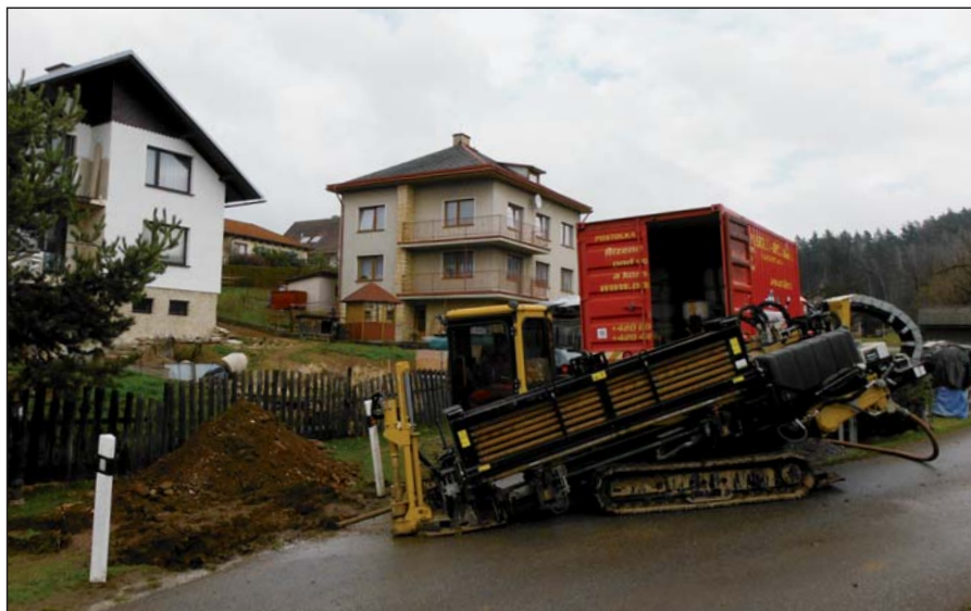
Moderní technika provedla řízený podvrt na Výsluní
